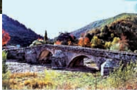
Fig. 17.- BOCA DE HUÉRGANO: Puente medieval. (Foto: A. P.)
