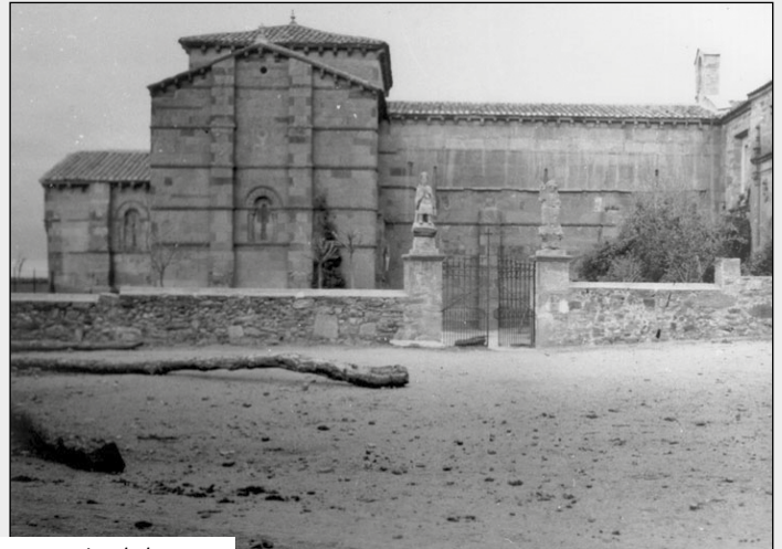
Aspecto exterior de la capilla mayor (izquierda), ya sin escalera y espadaña adosada, y lateral norte de la iglesia (superior), tras la restauración de 1933 / Fototeca Fundación Joaquín Díaz
