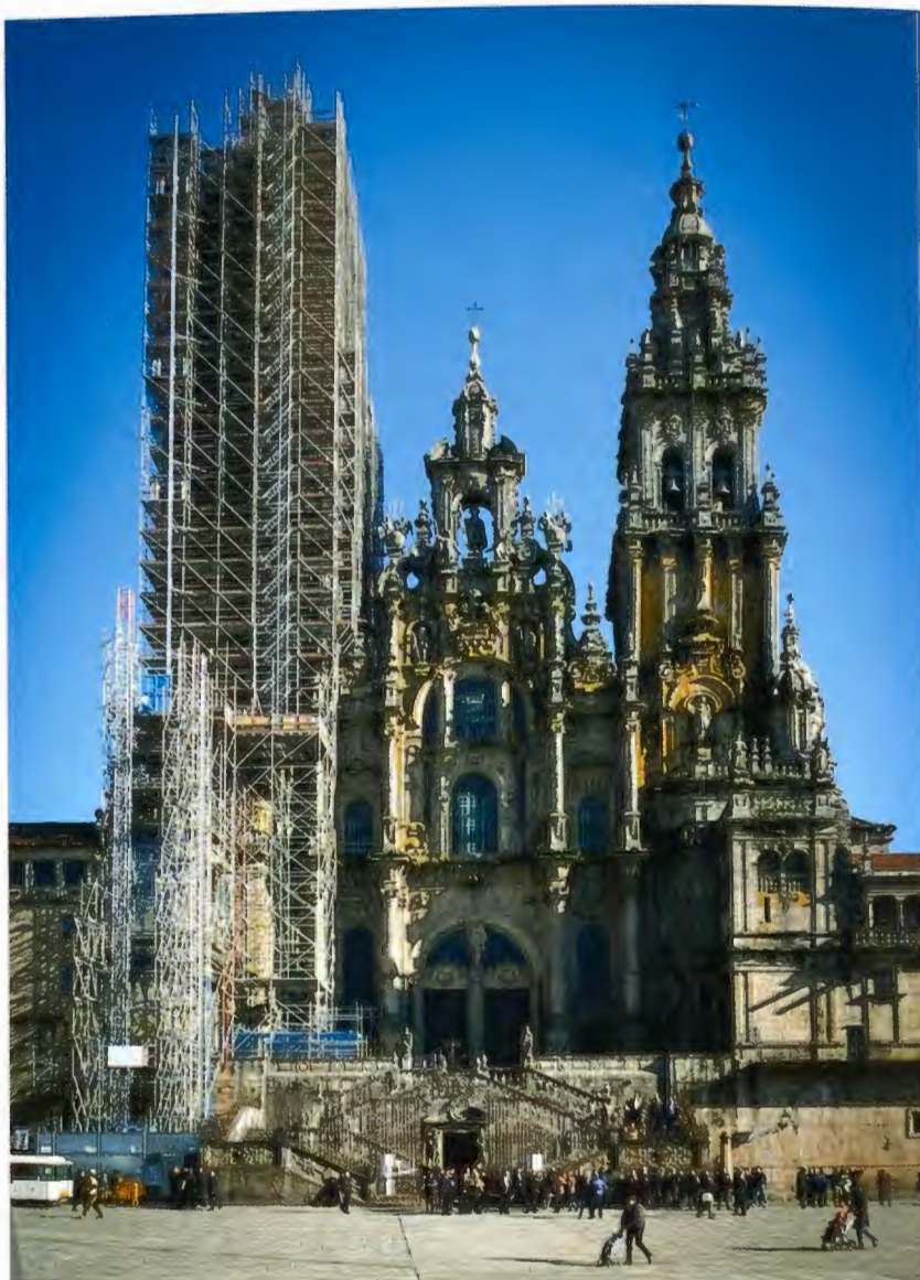
Restauración de la fachada del Obradoiro (tomada de Layher S.A.).
