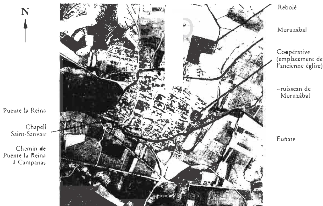
Vue aérienne de Obanos (Mairie).
