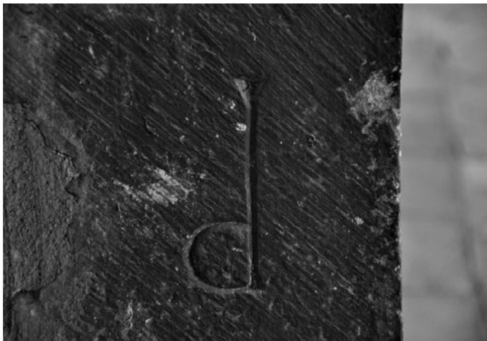
Fig. 7. Marca de cantero románica en el sobreclaustro de la catedral de Pamplona.
