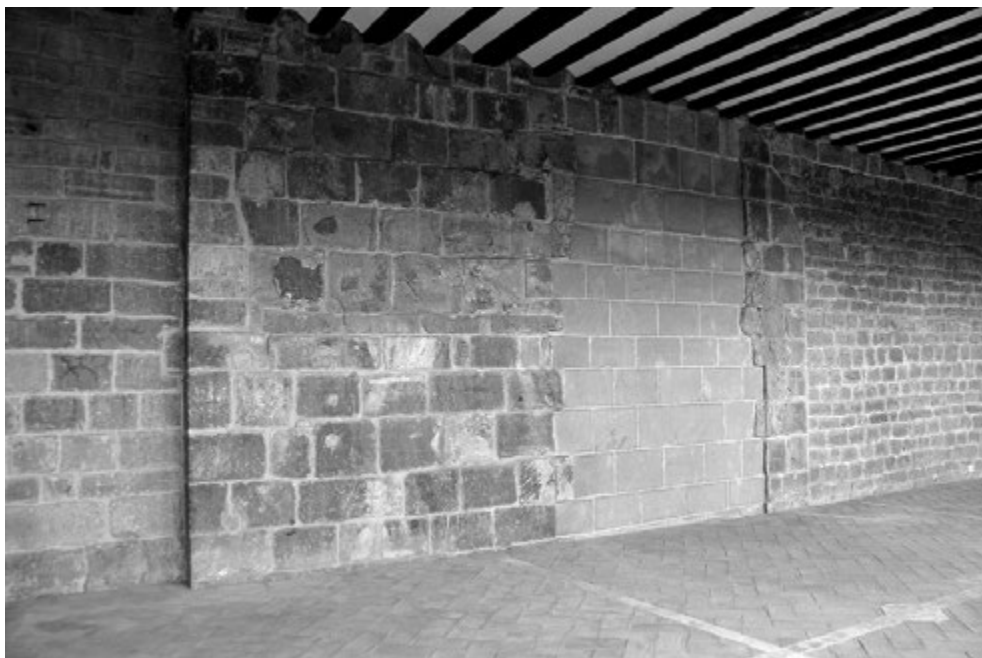
Fig. 6. Paño mural románico visible en la galería oriental del sobreclaustro de la catedral de Pamplona.
