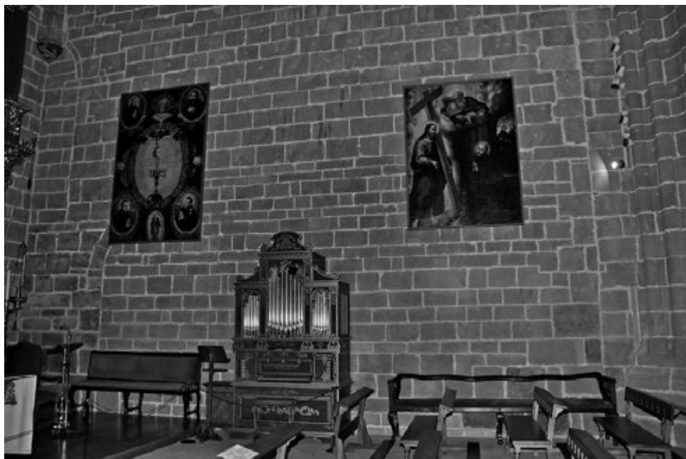
Fig. 5. Muro meridional del transepto en cuyos extremos se aprecian vestigios de la fábrica románica.
