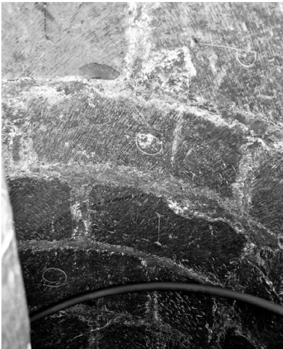
Fig. 10. Sillares románicos con marcas de cantero en el interior de la escalera de caracol.
