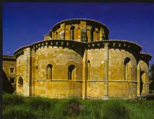
Vista exterior de los ábsides que cierran la cabecera del monasterio de Gradefes.
