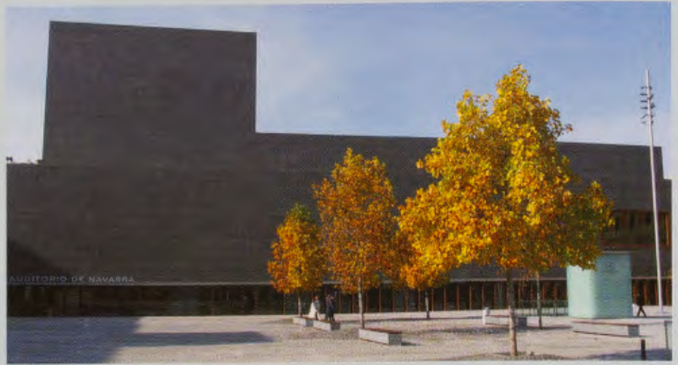
Un detalle del Baluarte, moderno auditorio y palacio de congresos (2003) con su fachada revestida de piedra negra procedente de Zimbawe.
