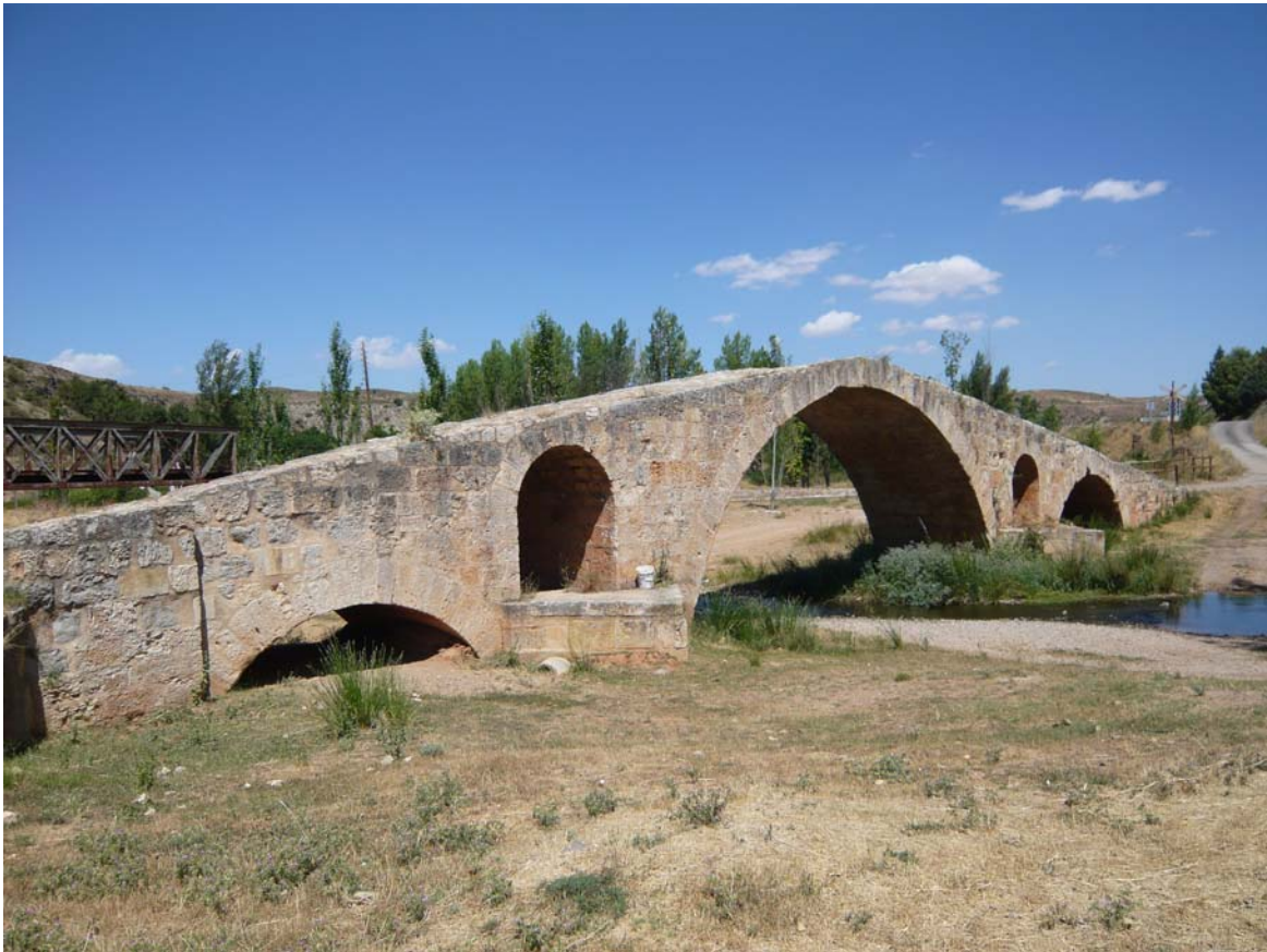
Puente romano de Luco de Jiloca
