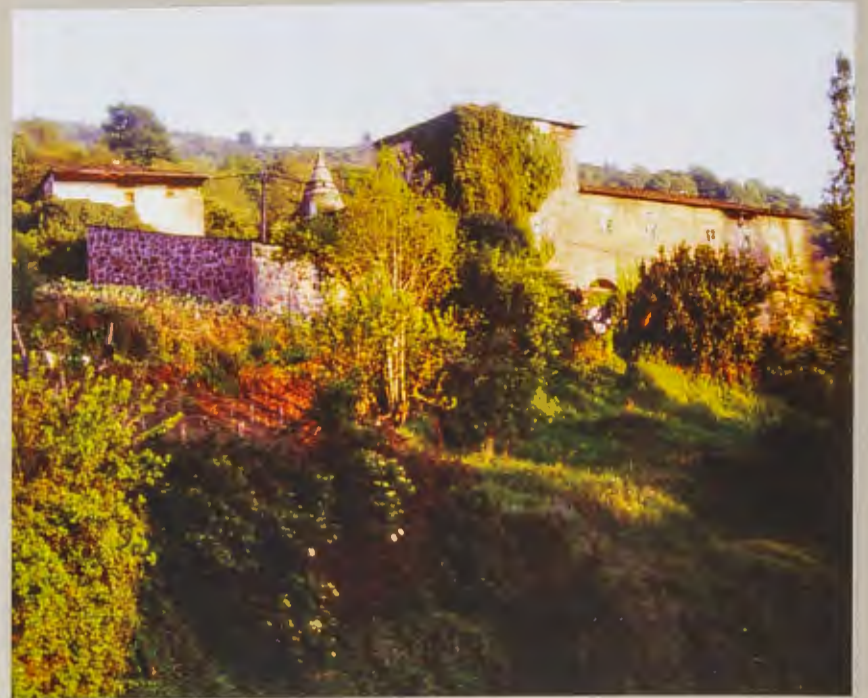
Imagen antes de las obras de rehabilitación.
