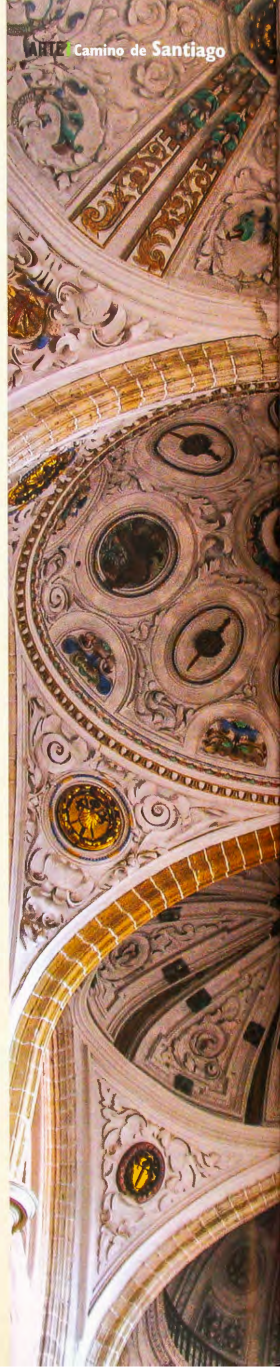
Felipe Berrojo. Cubiertas barrocas con decoración de yeserías de Santiago de Medina de Rioseco.
