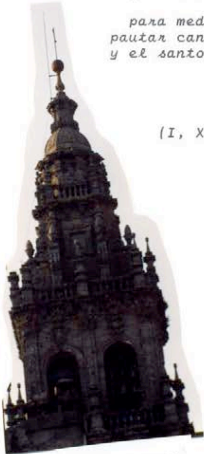
Torre de la fachada barroca.
