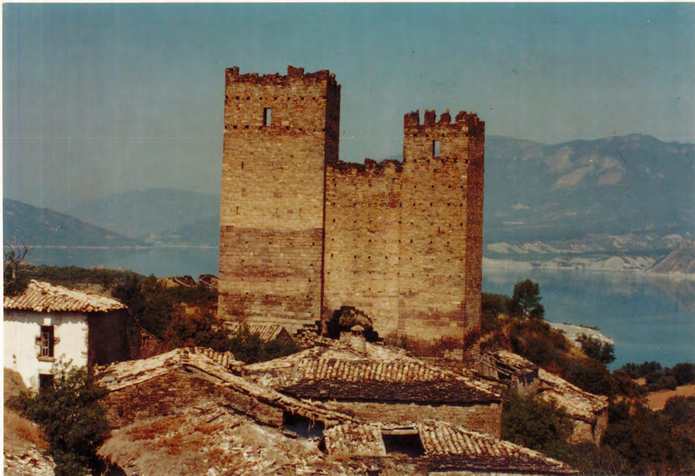
22. Ruesta. Château et vue d'ensemble de la petite ville abandonnée sur la rive gauche du barrage de Yesa. J.P. 1986.
