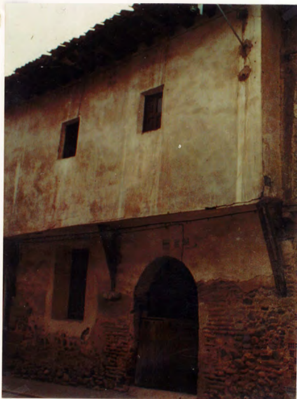
87. Redecilla del Camino. Village dont la Calle Mayor , étroite et longue, est bordée de maisons à encorbellement. J.P. et A.H., C.V. 1983.
