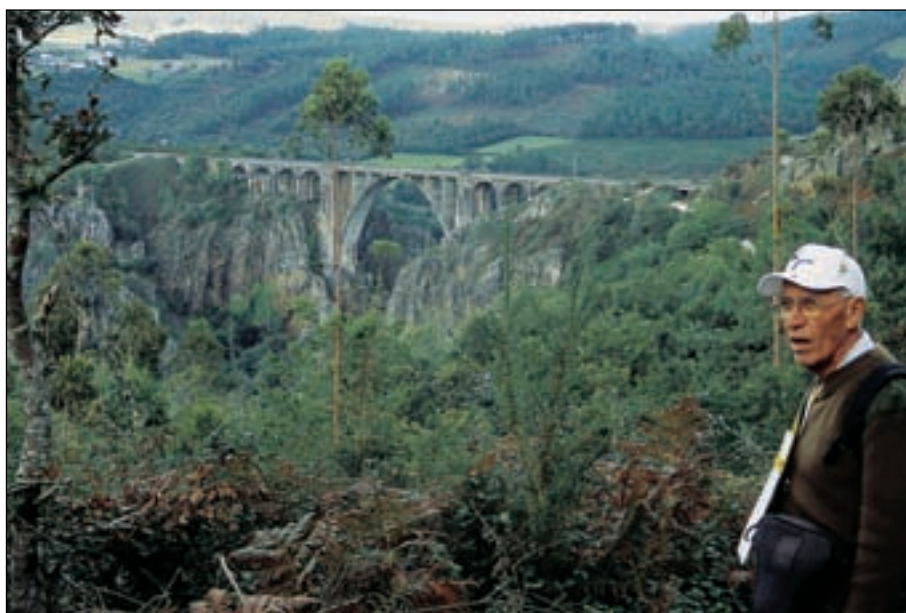
PUENTE DE ULLA : Viaducto sobre el tajo del río Ulla. (Foto: Rosalía Orense)
