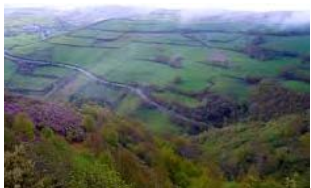
Figuras 7-8: Detalles del camino y entorno
