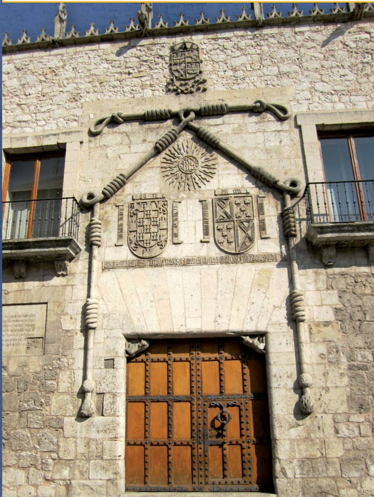
PALACIO DE LOS CONDESTABLES. Casa del Cordón
