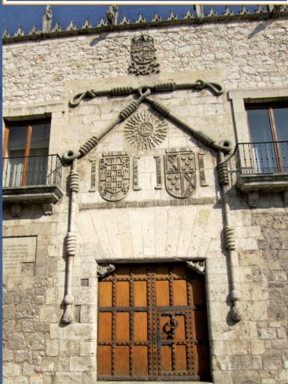
PALACIO DE LOS CONDESTABLES. Casa del Cordón
