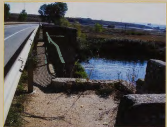
¿Pretil? del puente del Arzobispo.
