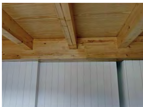
Forxado de madeira nunha vivenda rehabilitada
