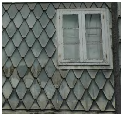
Paramento cuberto con escamas de cinc
