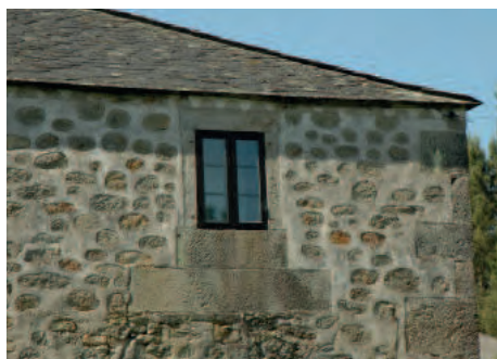
Encintado de morteiro de cal sobresaíndo do plano do muro nunha casa en Santa Locaia de Parga, Guitiriz
