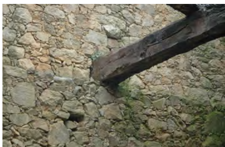
Apoio dunha viga de madeira na repisa formada polo estreitamento na parte superior dun muro de cachotería
