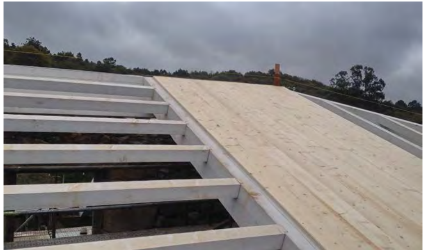
Rehabilitación de cuberta con estrutura de madeira
