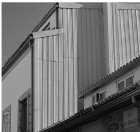
Protección dunha medianeira con pranchas metálicas
