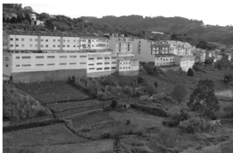
Os volumes desproporcionados destas edificacións construídas ao longo da estrada que conduce a un dos núcleos urbanos do camiño arruínan a paisaxe da súa contorna
