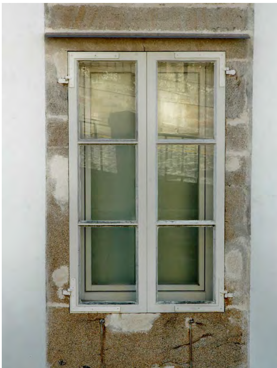
Rehabilitación dunha ventá tradicional con incorporación de dobre ventá polo interior
