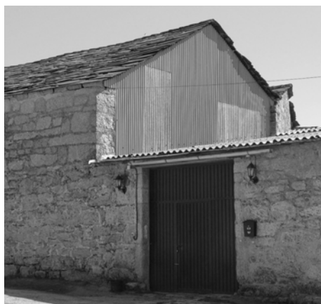
Peche dun pinche con pranchas onduladas de aceiro e de poliester
