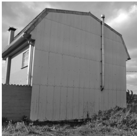
Muro medianeiro recuberto con prancha ondulada de fibrocemento
