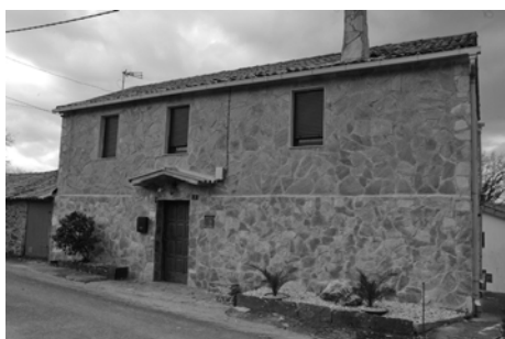
Chapado de pedra cun despeçamento que imita a fábrica de cachote
