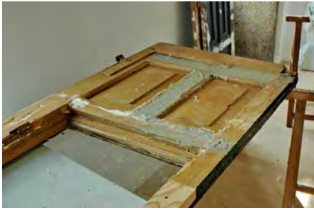
Rehabilitación dunha ventá tradicional mediante a substitución das partes deterioradas por novas pezas de madeira
