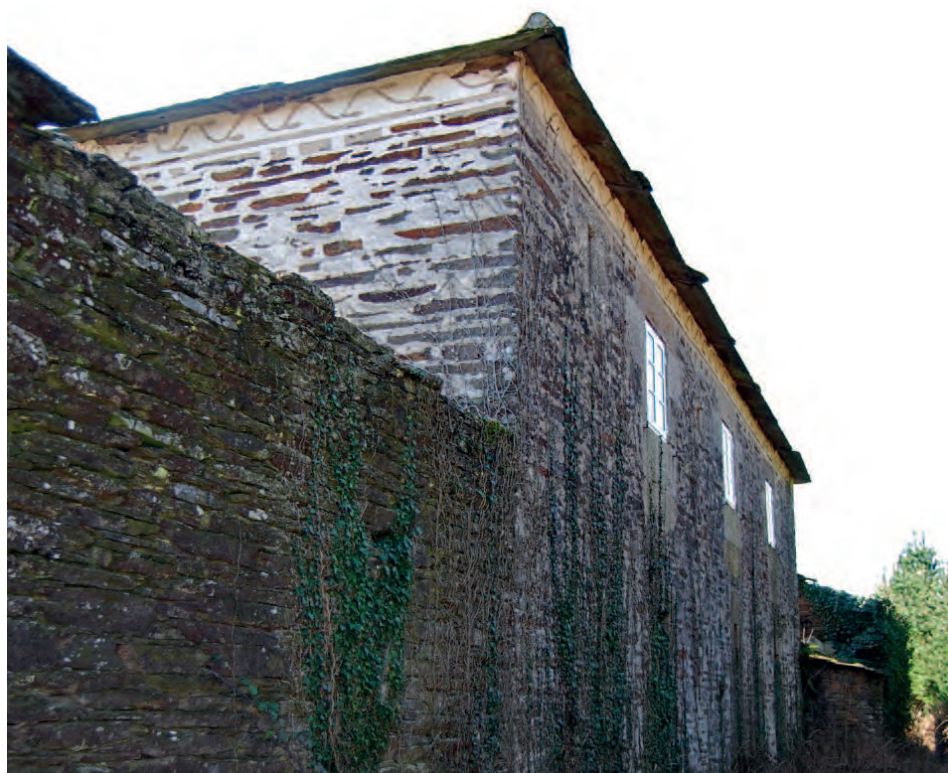
Encintado de cal con greca ornamental baixo o beiril nunha casa de Ferreira de Negral, Palas de Rei
