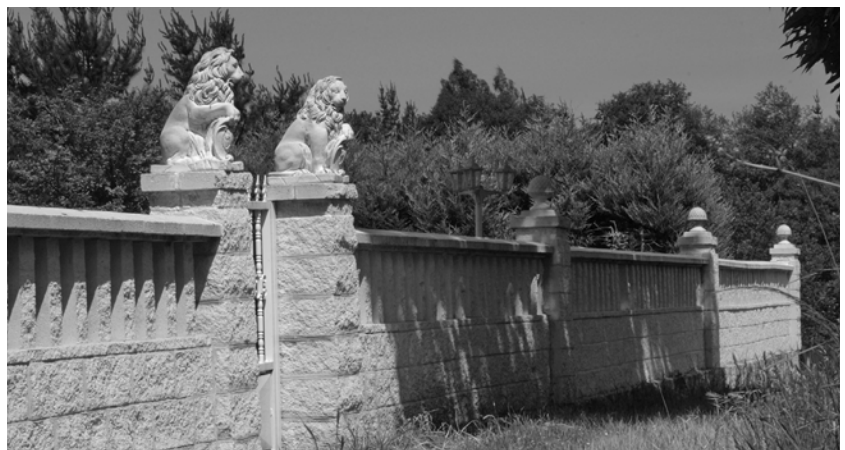
Peche de bloque rugoso con pilastras que incorpora elementos ornamentais sen sentido ningún
