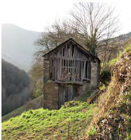
Palleira con cerramentos de madeira para a ventilación do espazo interior
