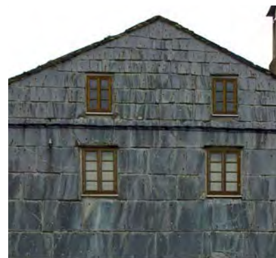
Pinche protexido con pezas de lousa fixadas con ancoraxes de aceiro
