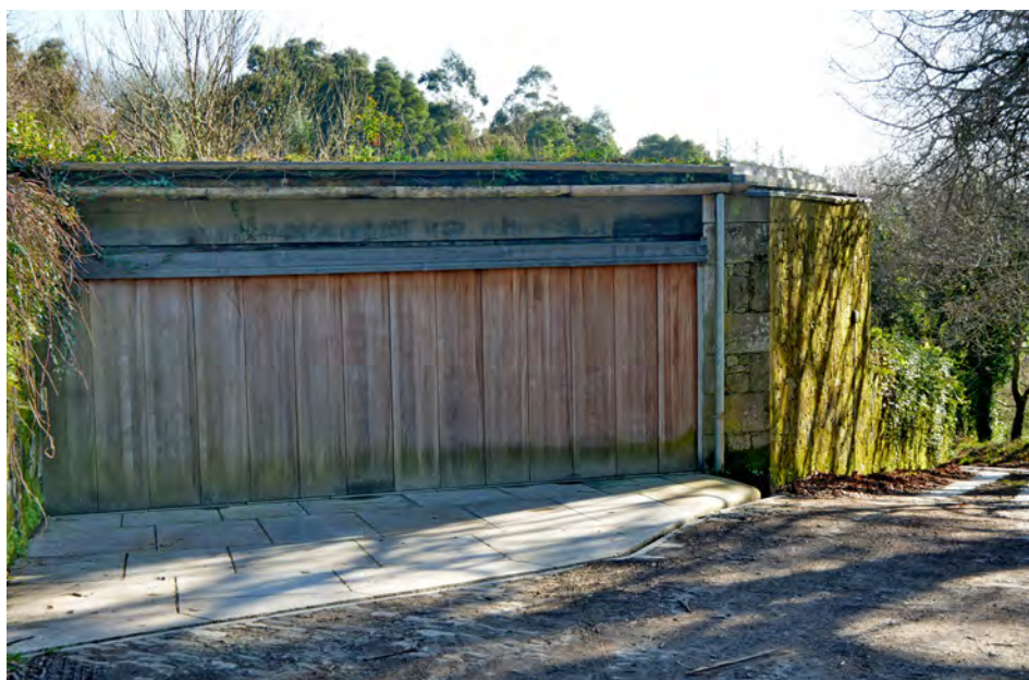
Garaxe dunha vivenda situada na contorna do Camiño de Fisterra en Santiago de Compostela. A utilización adecuada de materiais tradicionais permite a súa perfecta integración na paisaxe rural
