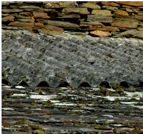
Utilización de pranchas de fibrocemento na reparación dunha cuberta de lousa
