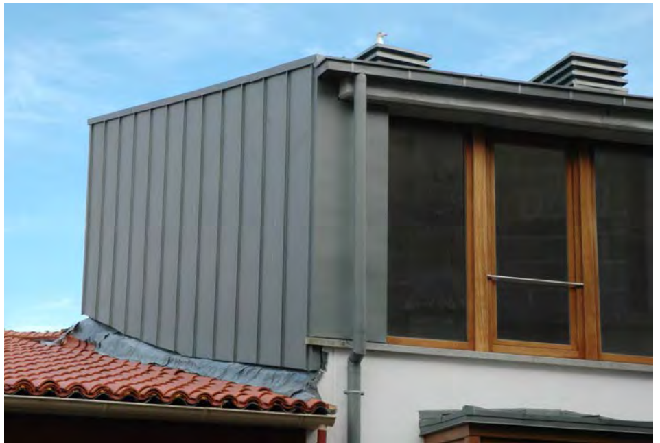
Protección da parte superior do muro medianeiro nun edificio no casco histórico de Betanzos mediante pranchas de cinc
