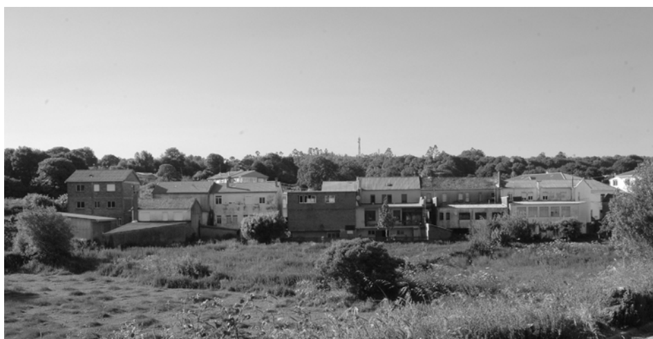
Vista de conxunto das fachadas traseiras das vivendas dun núcleo urbano. Á falta de unidade, producida polo uso desacertado da cor e polos engadidos de carácter irregular, hai que sumarlle a falta de decoro que producen as edificacións sen revestir
