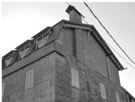
Incremento do volume do baixo cuberta mediante a modificación do perfil da cuberta
