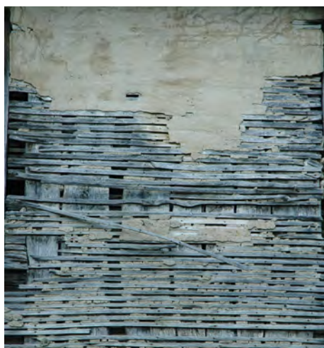
Imaxe dun tabique de barrotiño que perdeu parte do seu revestimento deixando á vista a estrutura de montantes e listóns de madeira
