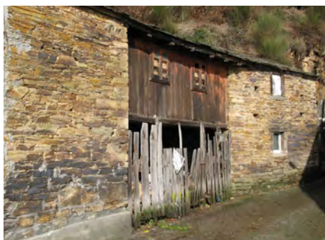
Construción de madeira entre dous corpos de fábrica de cachotería nunha vivenda tradicional
