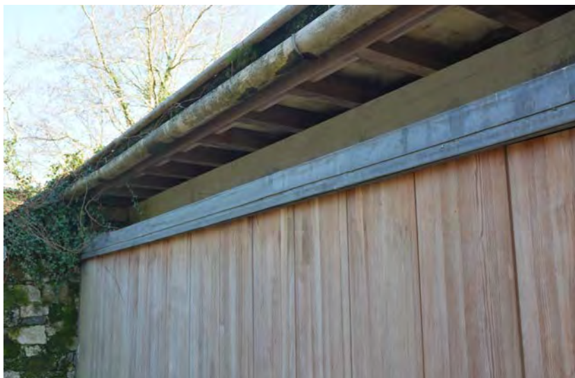
Nova edificación no Camiño de Fisterra no seu inicio en Compostela, na que ten especial interese o deseño do beirado coa estrutura de madeira vista e o canlón do mesmo material
