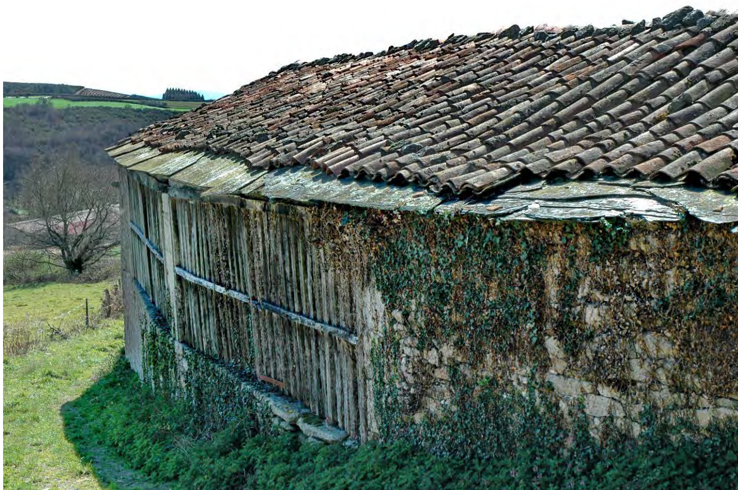
Solución de beirado característica de zonas de transición entre as cubertas de xisto e de tella. O beirado está formado por grandes laxes de xisto sobre as que solapan as tellas retrasadas. Aguas Santas, Palas de Rei
