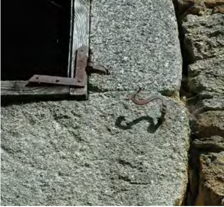
Detalle de bisagra e fiador dunha ventá tradicional
