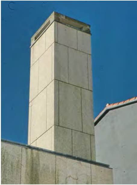
Solución correcta de chimenea contemporánea con acabado de aplacado de granito
