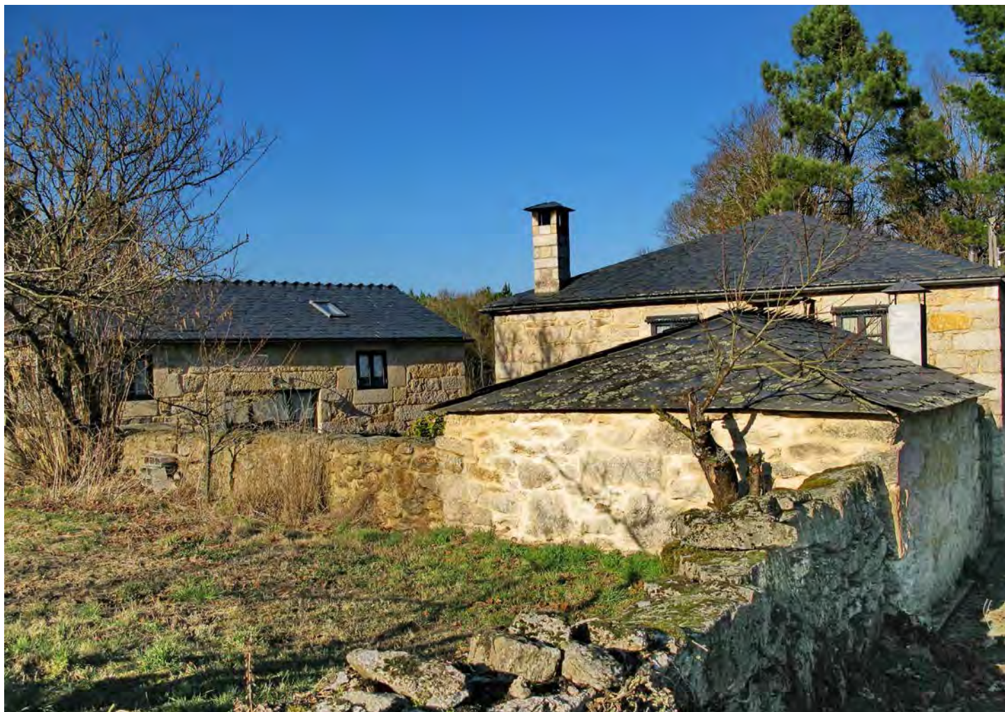
Conxunto de edificacións con cubertas de xisto correctamente rehabilitadas
