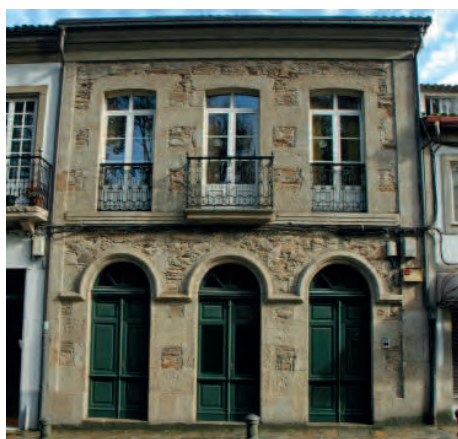
Fachada urbana na que se eliminaron os revestimentos de morteiro de cal deixando as partes de cachotería á vista
