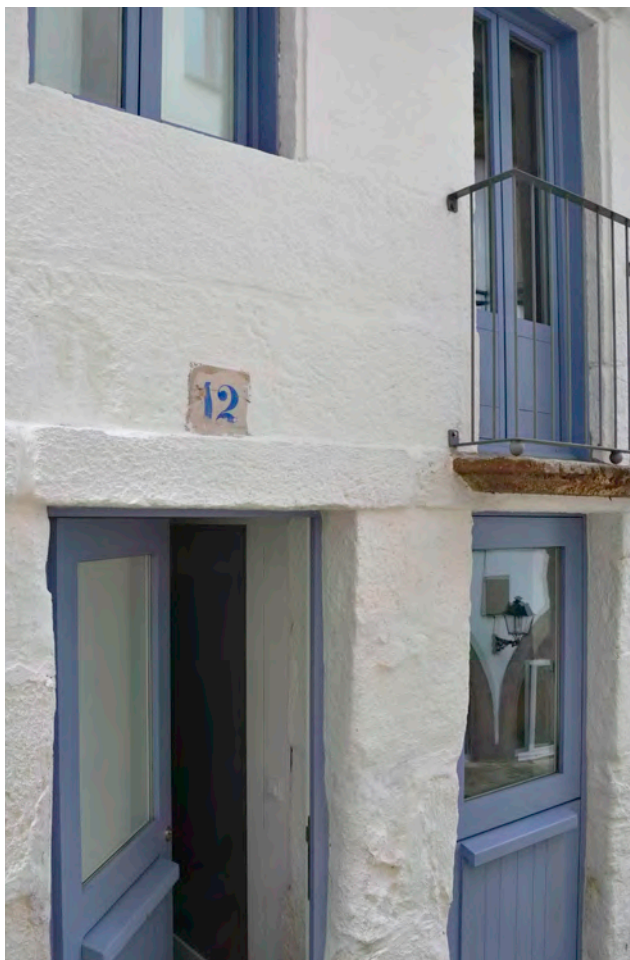
Fachada de vivenda rehabilitada con recuperación de encalado tradicional
