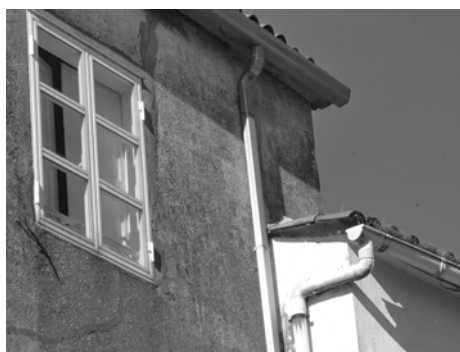
Canlón de aluminio con sección en forma de cornixa e canlón de PVC
