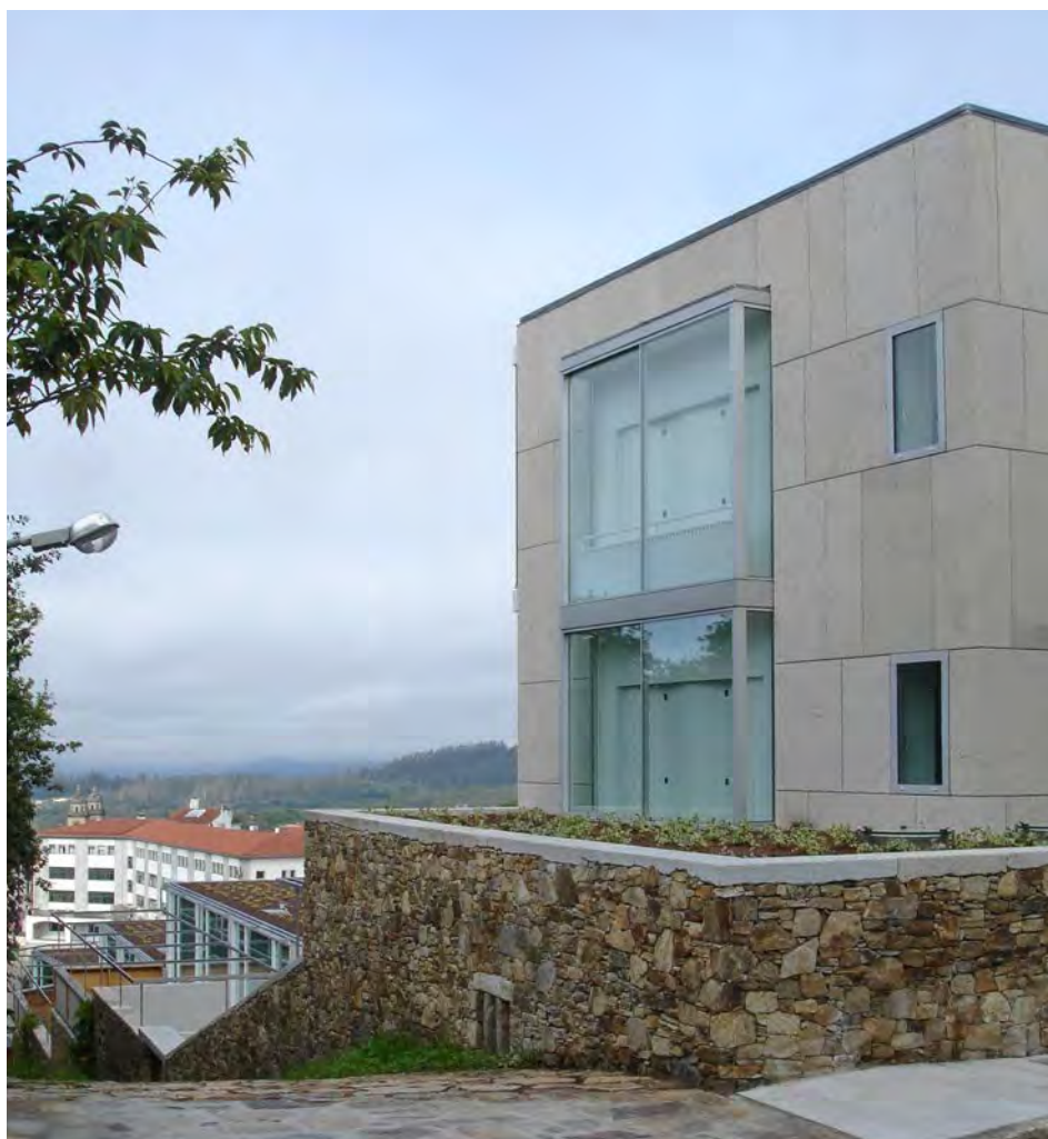
Fachada de aplacado de granito nunha construción contemporánea
