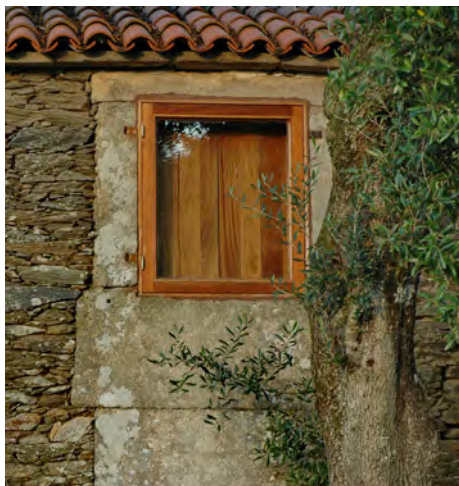
Ventá de madeira nunha rehabilitación con contra interior de madeira
