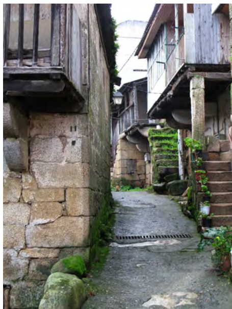
Casas con patíns e corredores nunha rúa
