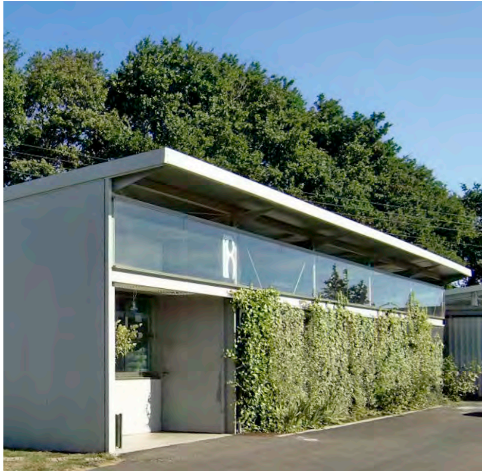
Nave de estrutura e cerramentos metálicos na que o adecuado estudo da implantación e das solucións construtivas contribúen á súa integración na contorna
