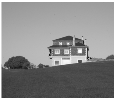
Vivenda que ignora a topografía. A planta baixa demasiado alta e a construción do segundo andar fan que a vivenda resulte desvinculada do terreo e cun volume excesivo. A utilización de aplacados que imitan cachotería de lousa e os esquinais e cercos de chapado de granito resultan, así mesmo, desacertados
