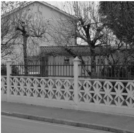
Peche de formas complexas que combina elementos prefabricados de formigón, xa desafortunados en si mesmos, con postes e unha reixa metálica
