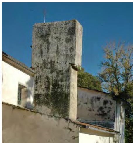
Cheminea de gran tamaño con sistema interior para evitar a entrada da auga de choiva. Santiago de Compostela
