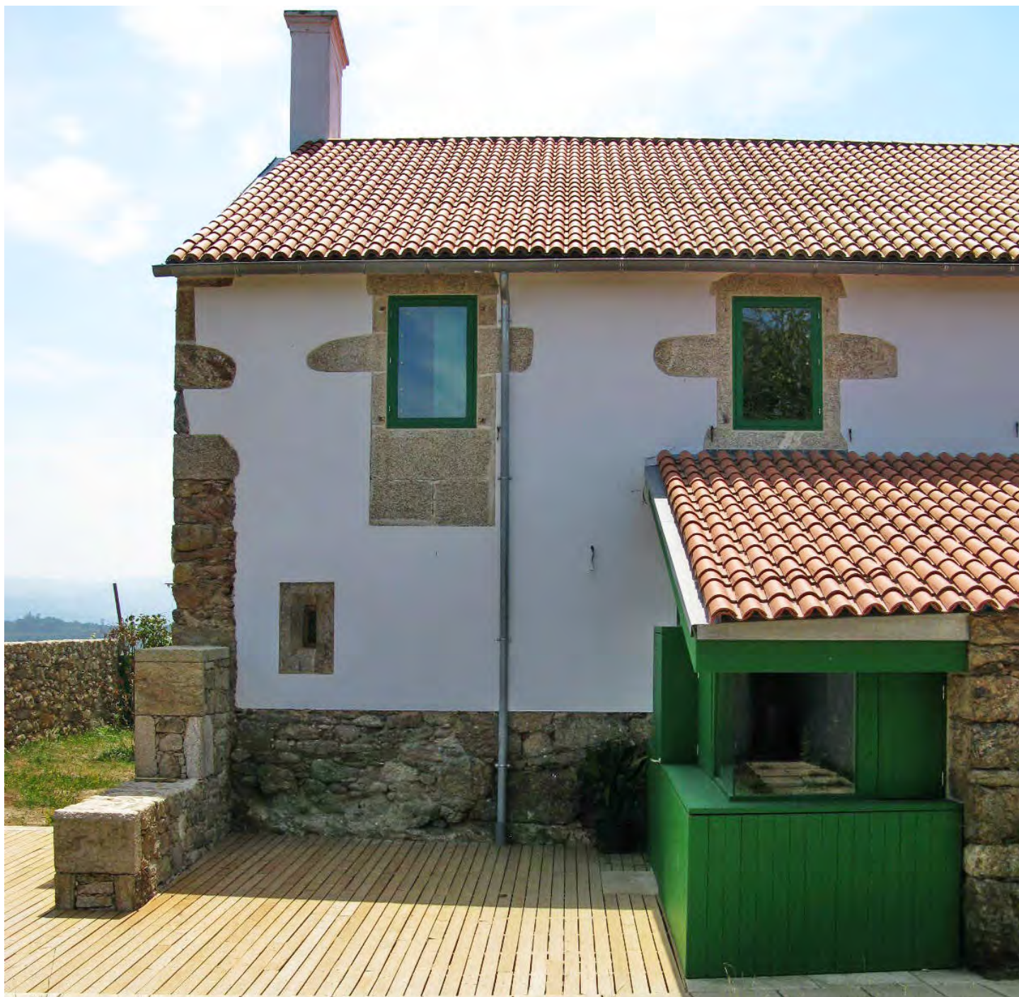
Vivenda rehabilitada con canlóns e baixantes de cinc
