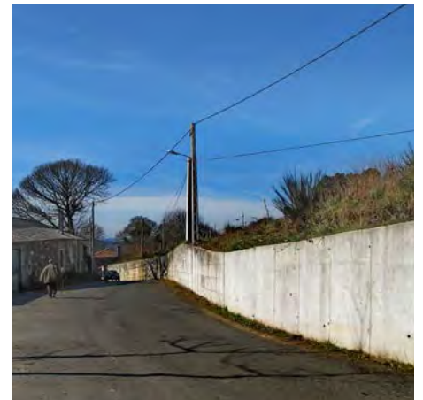
Muro de contención de formigón de execución descoñecida
