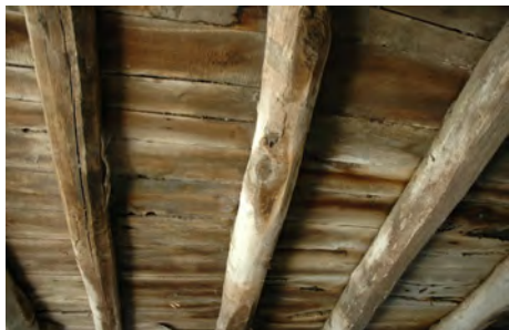
Vista da parte inferior dun forxado de madeira
