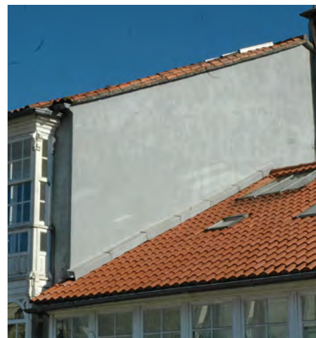
Protección de medianeira con revocadura
