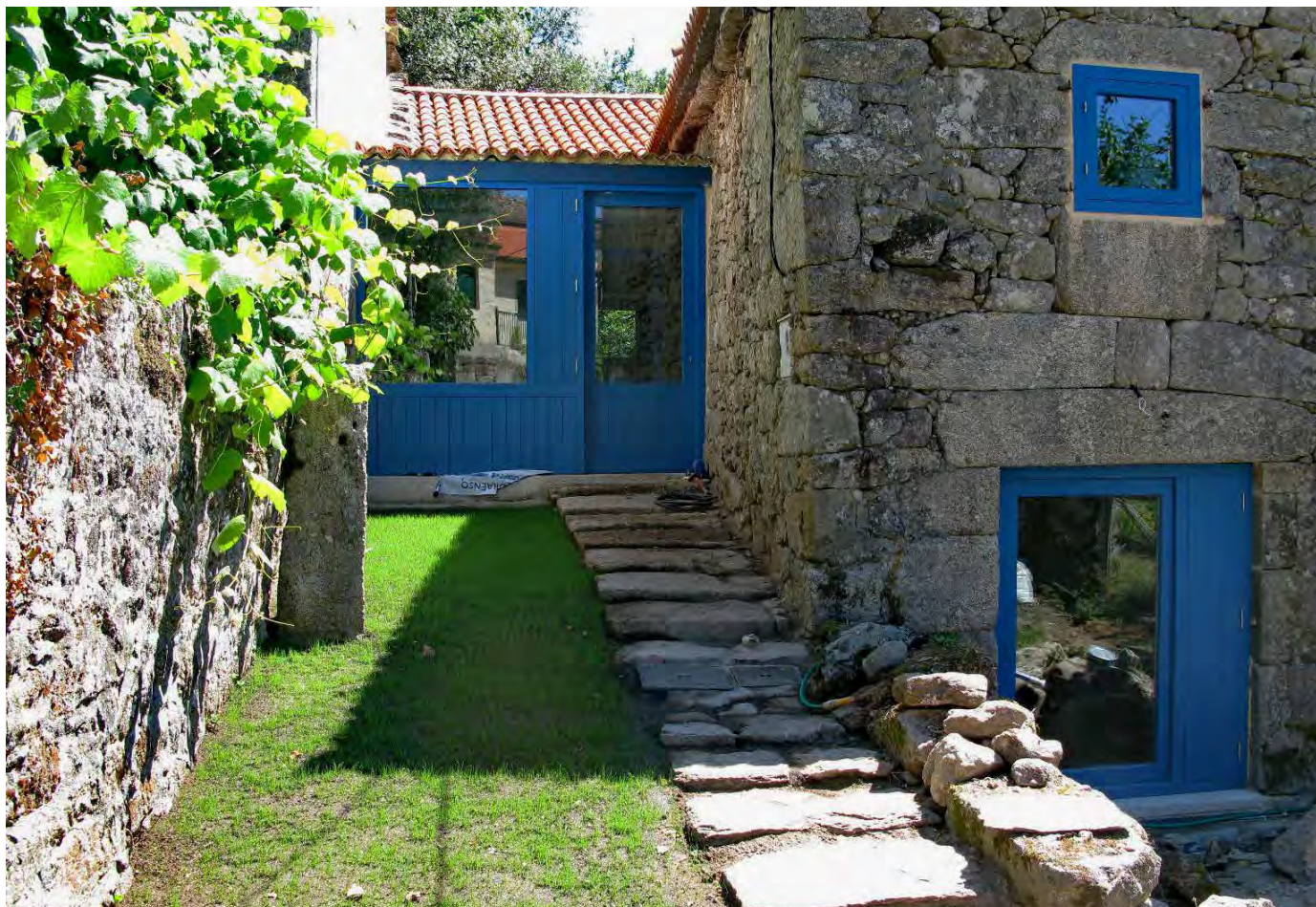
Carpintería de madeira pintada na rehabilitación dunha vivenda tradicional
