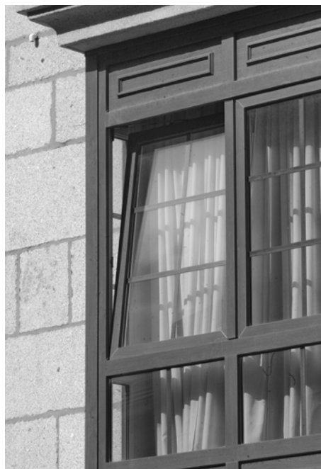
Carpintería de PVC que imita a textura da madeira
