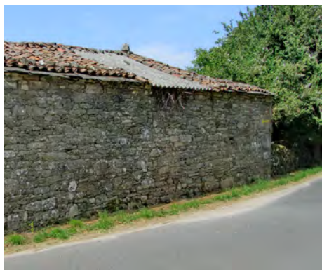
Reparación dunha cuberta de tella con pranchas de fibrocemento
