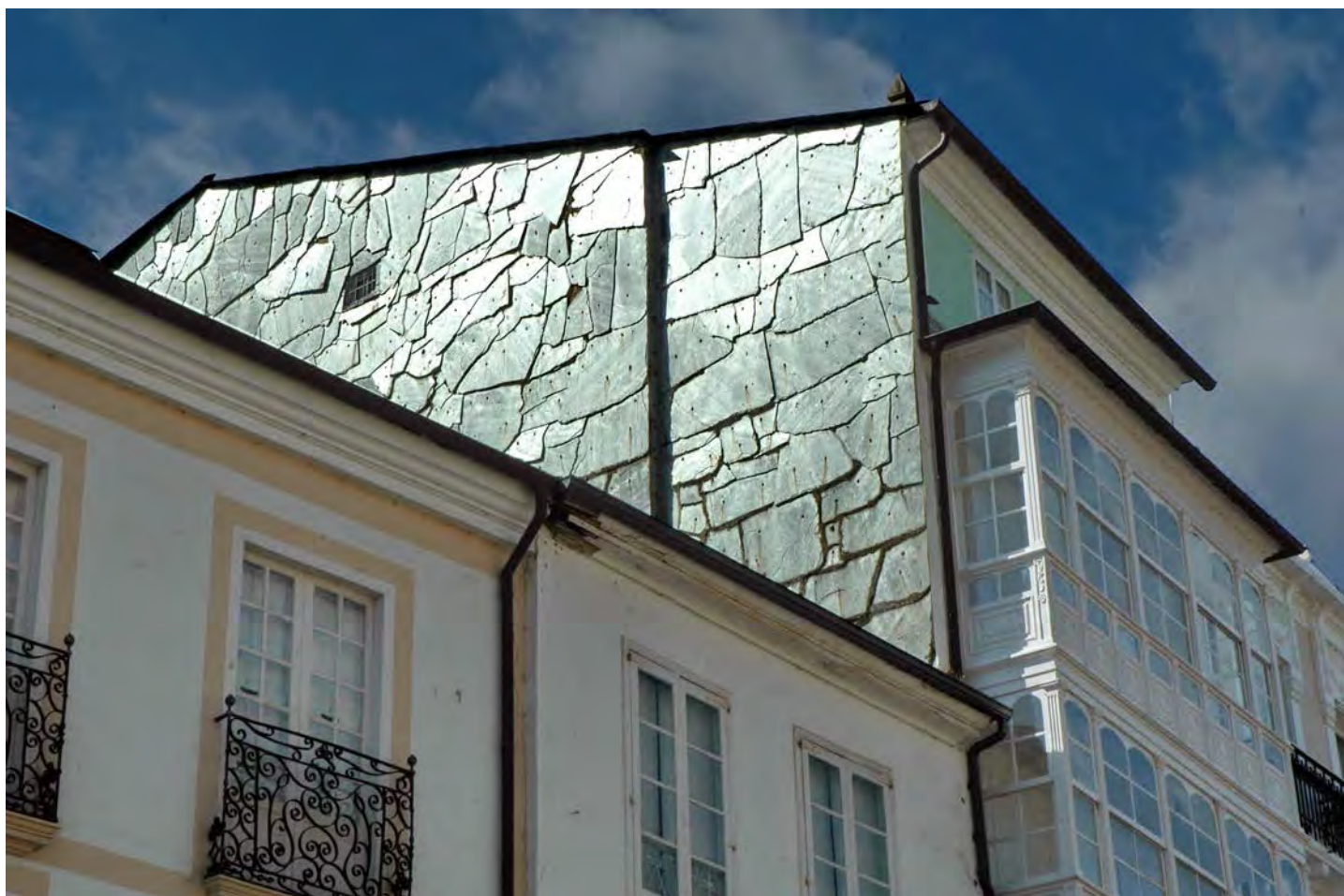
Cubrición do muro medianeiro con lousas con ancoraxes de aceiro. Mondoñedo
