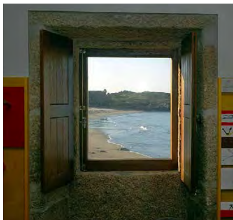
Utilización de contras de madeira nunha rehabilitación
