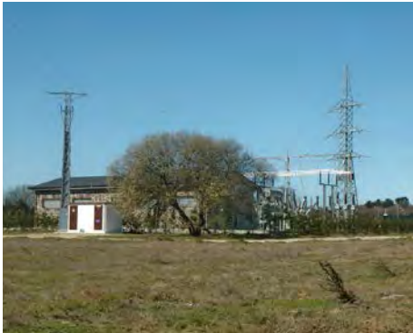
Centro de transformación no Camiño Primitivo ao seu paso por Lugo
