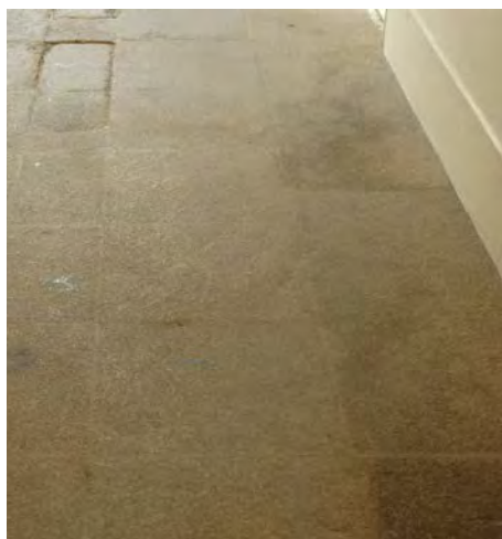
Pavimento de lousas de granito na planta terrea dunha vivenda
