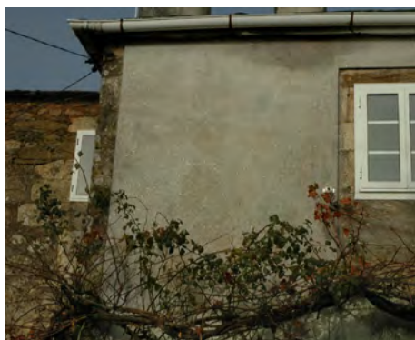
Revestimento da fachada dunha vivenda tradicional con morteiro de cemento
