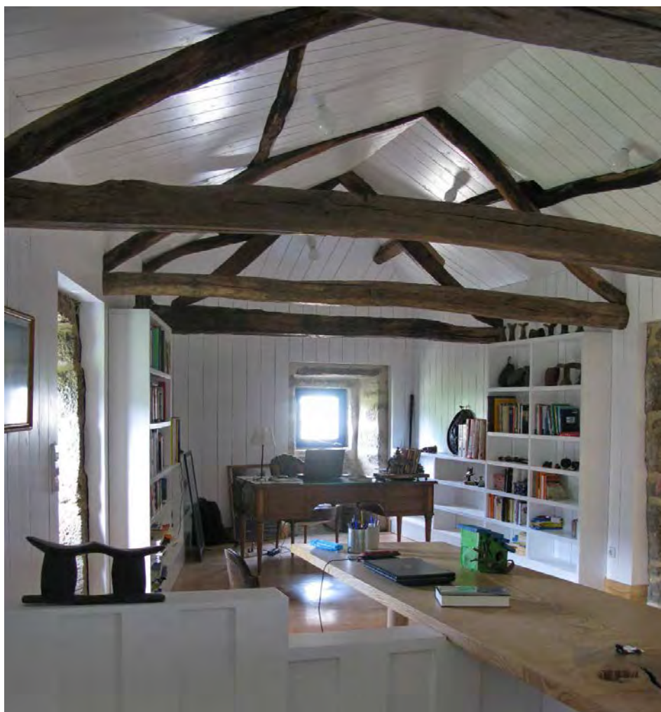
Rehabilitación de vivenda mantendo as tesoiras e os terzos orixinais
