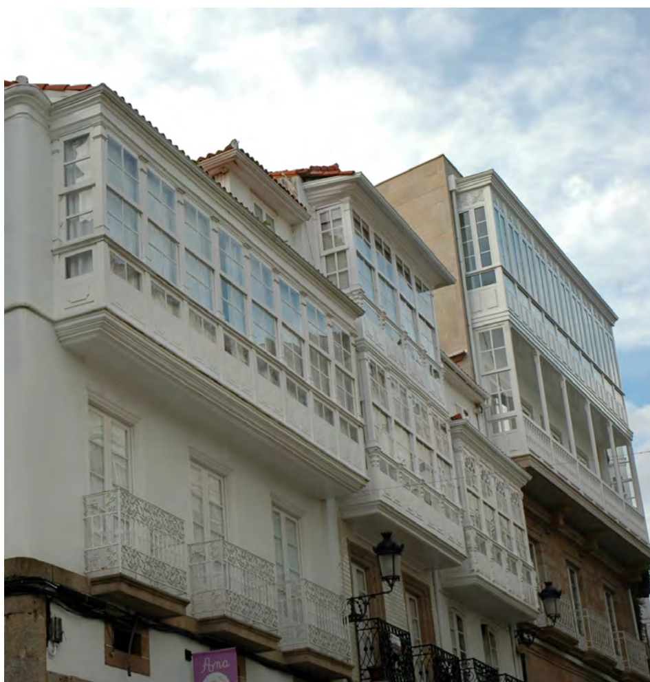
Exemplos de rehabilitacións correctas de galerías en Betanzos
