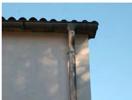
Solución correcta de canlón e baixante de cobre
