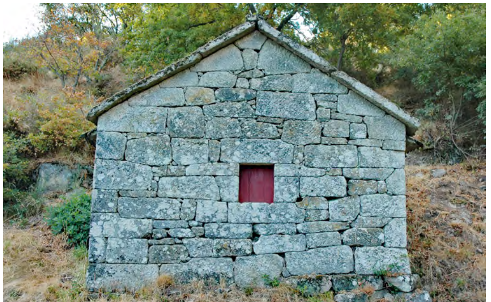
Construción con cuberta a dúas augas en Oseira, Cea
