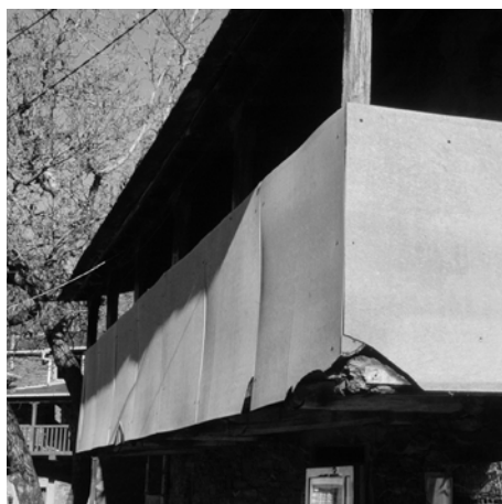
Substitución de varandas nun corredor por paneis de fibrocemento
