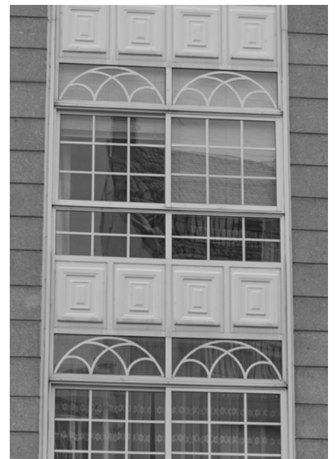
Carpintería de aluminio que imita ós plafóns e maineis dunha carpintería tradicional
