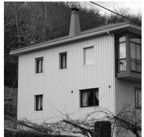
Parede ao sur protexida con paneis de chapa de aceiro
