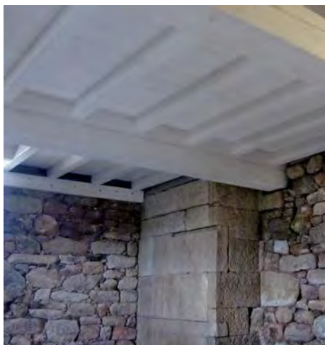
Rehabilitación con forxado de madeira
