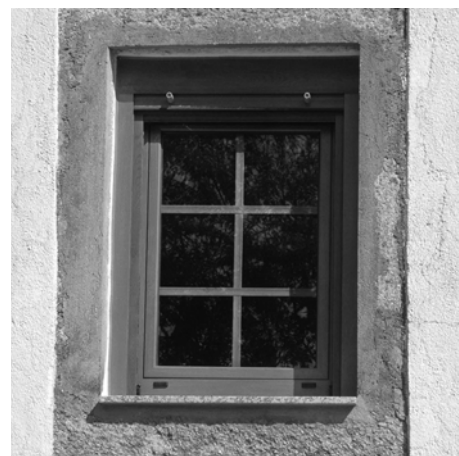
Substitución de ventá tradicional por carpintería de PVC con acabado que imita madeira
