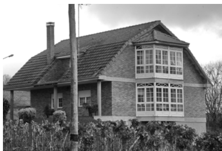
Vivenda con muros de ladrillo visto
