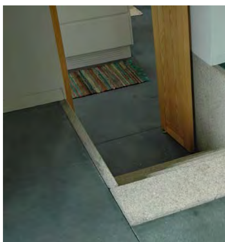
Pavimento de formigón coloreado e chanzos de granito na planta terrea dunha vivenda rehabilitada
