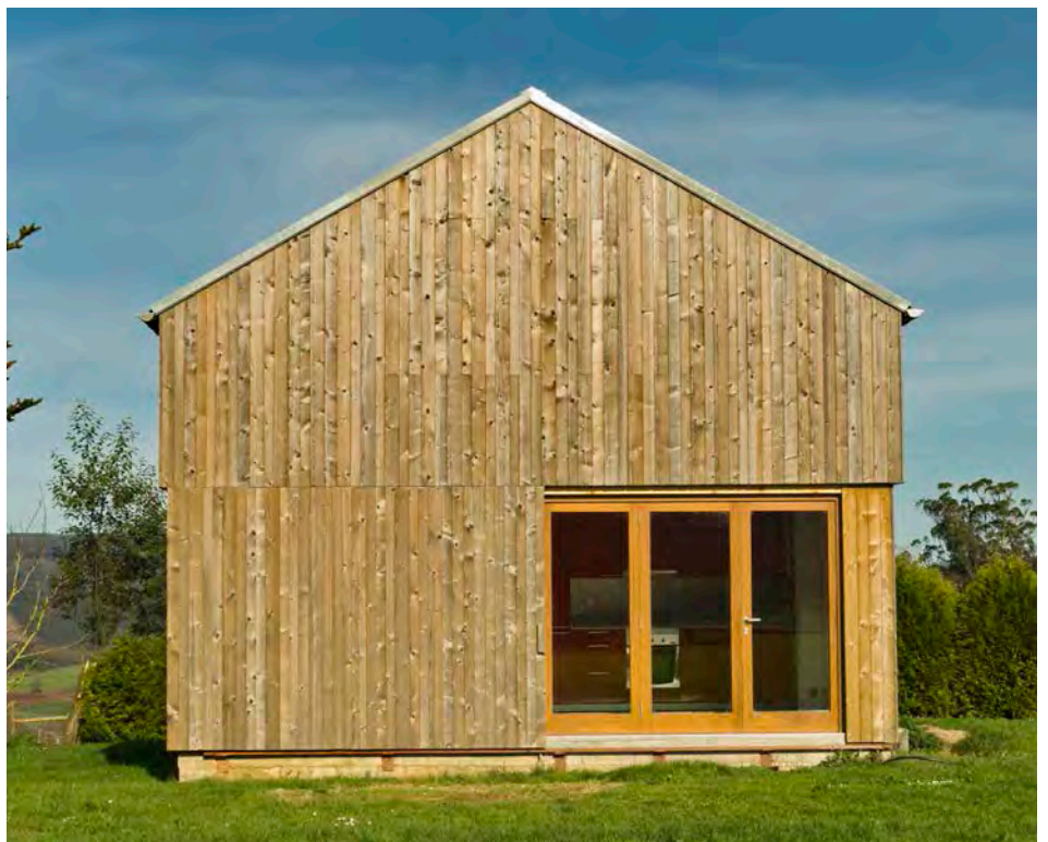
Nesta vivenda, de factura contemporánea, a utilización dunha cuberta a dúas augas e dun volume compacto contribúe á súa integración na paisaxe rural
