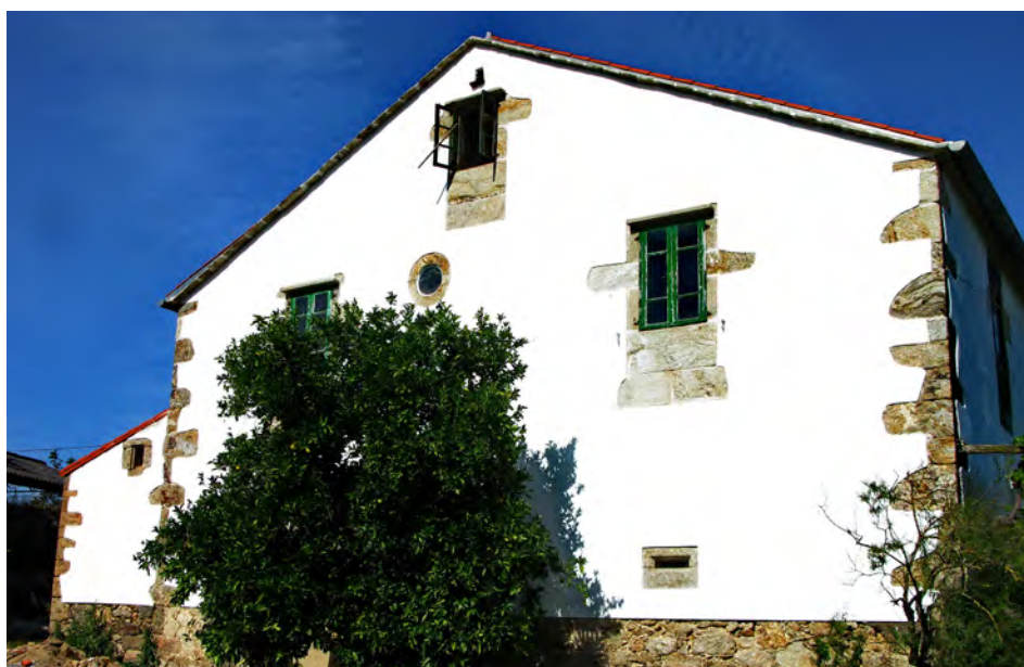
Vivenda rehabilitada na que os muros de cachotería se revisten con morteiro de cal
