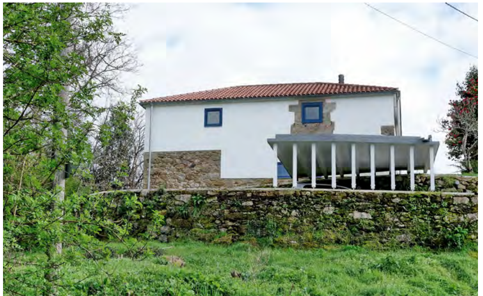
O novo garaxe desta vivenda rural, construído en madeira, aproveita os muros de contención existentes para conseguir a súa integración
