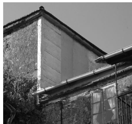
Protección dunha fachada con láminas asfálticas autoprotexidas
