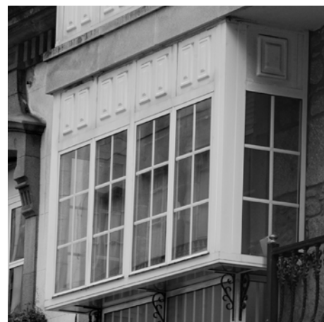
Substitución da madeira por aluminio na rehabilitación dunha galería
