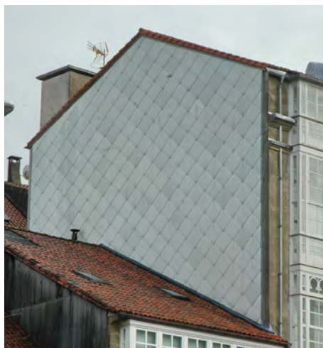
Protección de medianeira con escamas de fibrocemento
