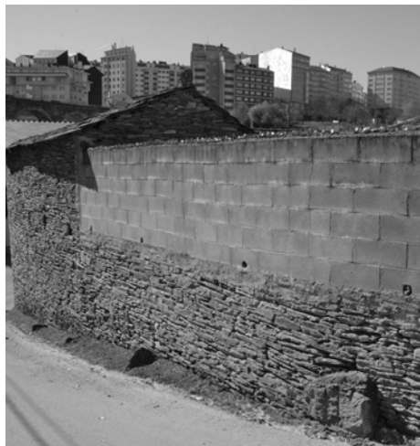
Incremento da altura dun muro de lousa con bloques de formigón
