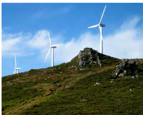
Parque eólico no alto de Hospital de Montouto, A Fonsagrada
