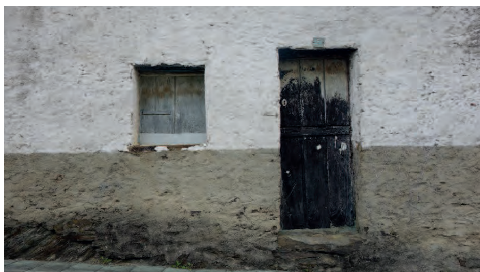
Revestimento dunha vivenda con morteiro de barro con acabado de cal
