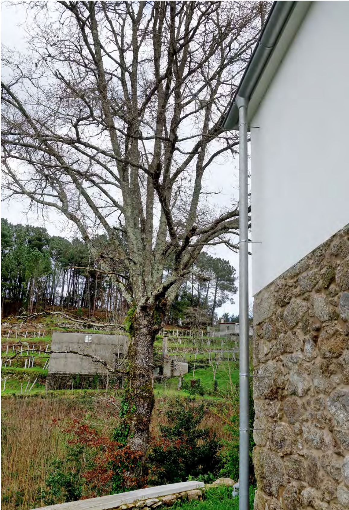
A utilización de canlóns e baixantes de cinc con formas sinxelas resulta a solución máis adecuada para as contornas tradicionais
