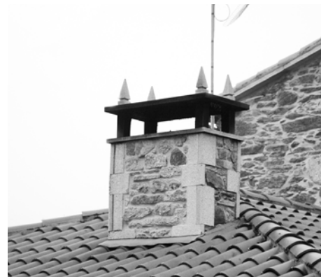
Cheminea de ladrillo con chapado de pedra que imita unha fábrica de cachotería con esquinais de cantería
