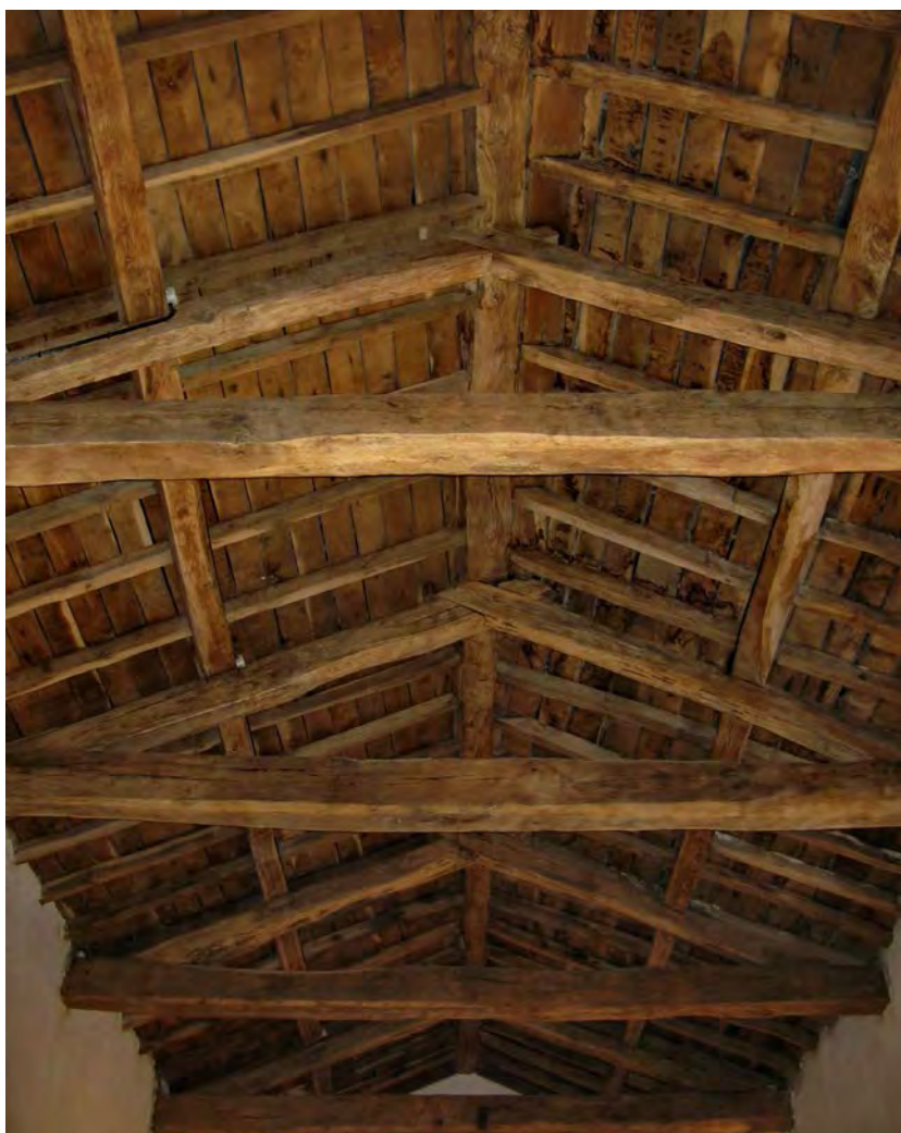
Estrutura de madeira dunha cuberta tradicional
