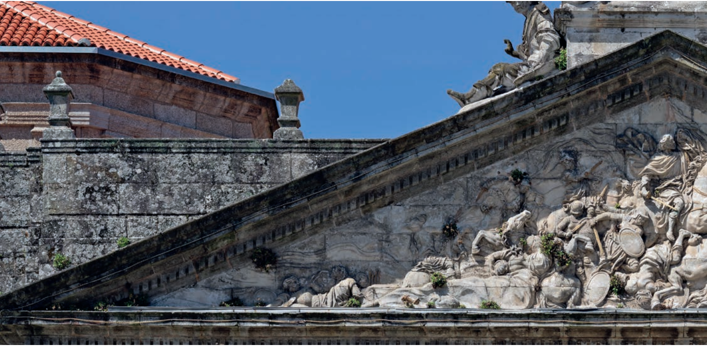
Fig. 3: Santiago en Clavijo del Seminario del arzobispo Rajoy, actual Edificio del Ayuntamiento de Santiago de Compostela. Foto: Ovidio Aldegunde.
