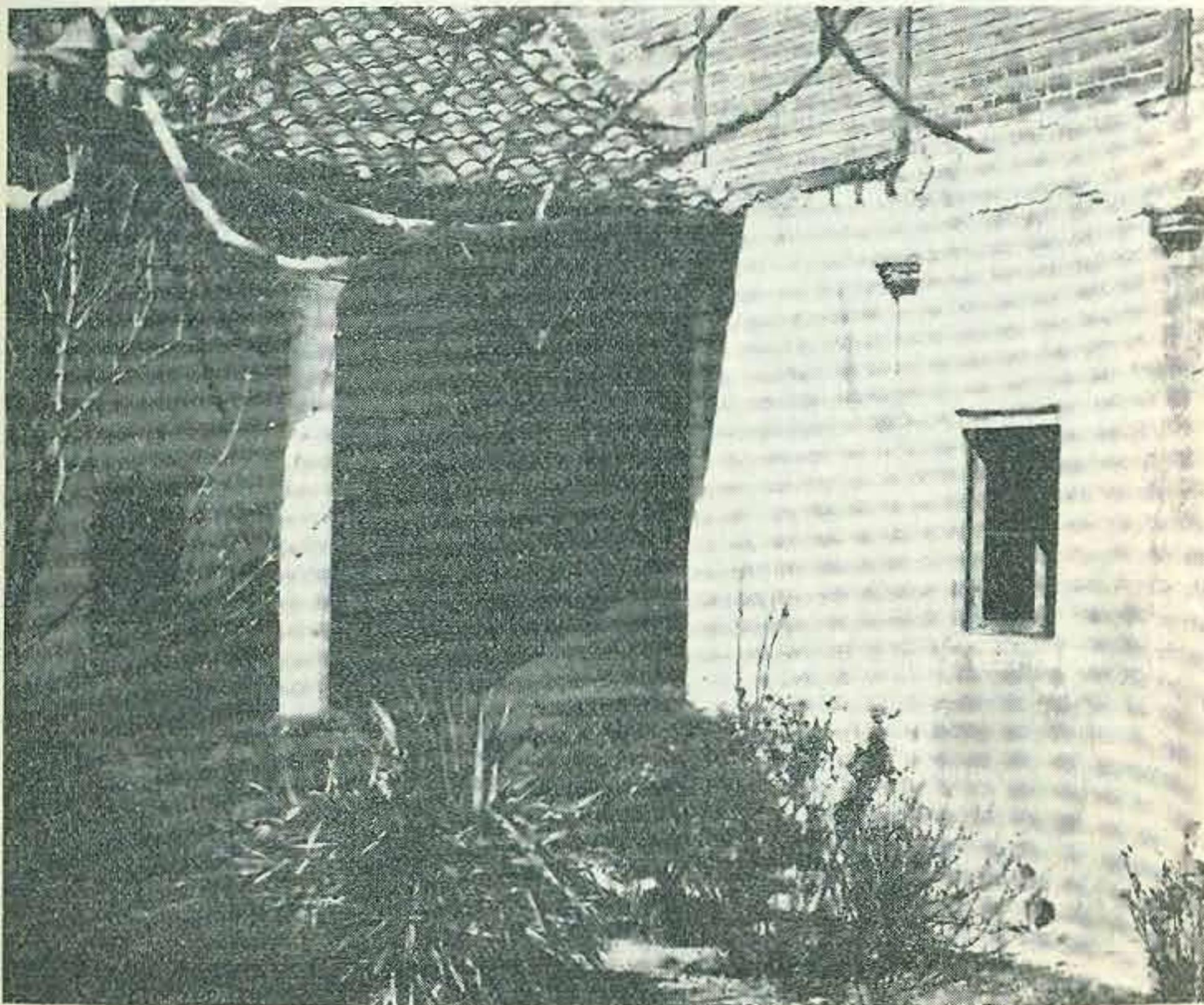
Patio del Hospital apreciándose parte de las columnas medio ocultas por nuevas paredes.
