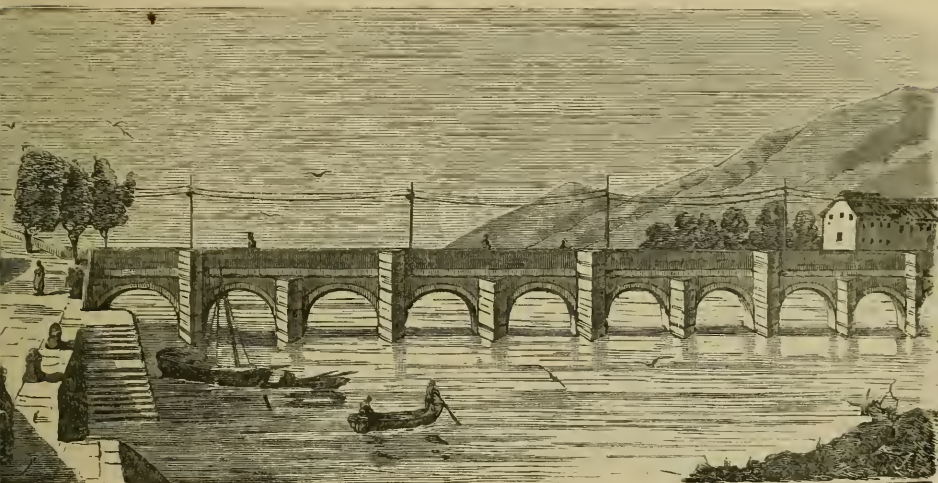
PUENTE DE CESURES.
