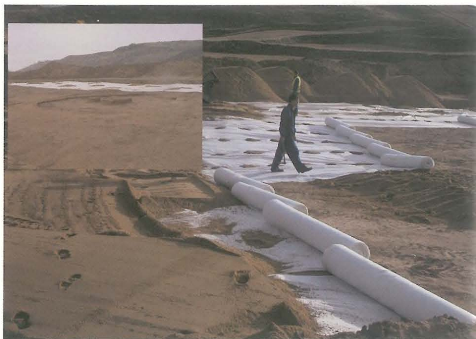
Protección con geotextil y cubrición del área de excavación.
