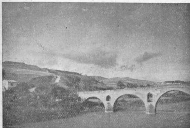
N.º 11. — Puente de la Reina. (Fot. "Photo Club", Burgos.)
