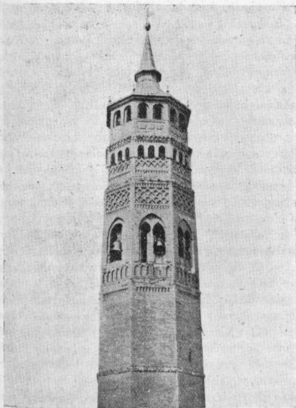
N.º 4. — Zaragoza. Torre de San Pablo
