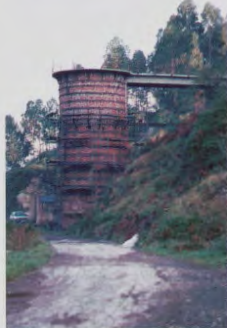
Horno de calcinación de la Mina José (Abanto-Zierbena)
