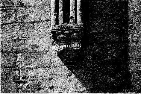
Figura 8: Detalle de una de las ménsulas del lienzo sur de la torre del Reloj, catedral de Santiago.
