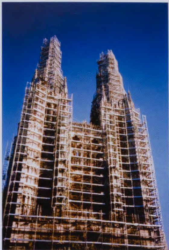
La Catedral cubierta de andamiaje. Enero 1995.
