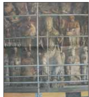
Andamios en Pórtico de la Gloria
