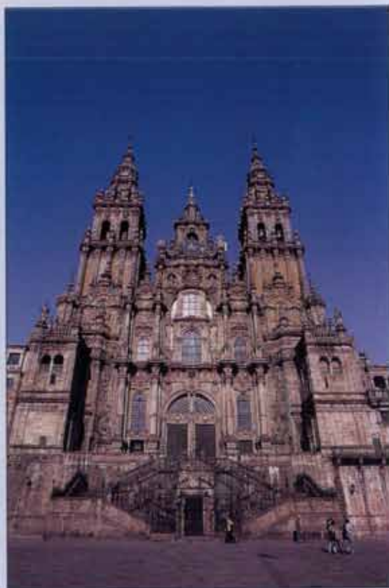
Fachada del Obradoiro
