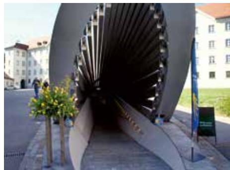
Eingang zum Pfalz-keller
