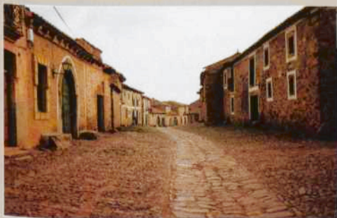
La Calle Real. Castrillo de Los Polvazares
