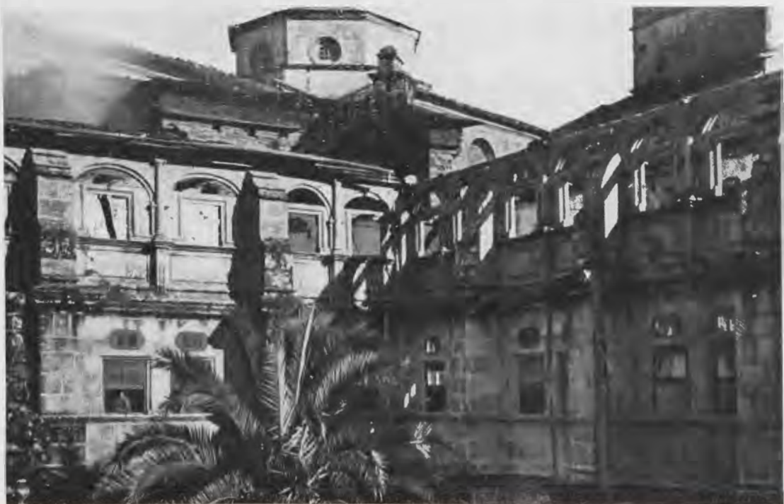
Samos. Patio interior del Monasterio, después del incendio
