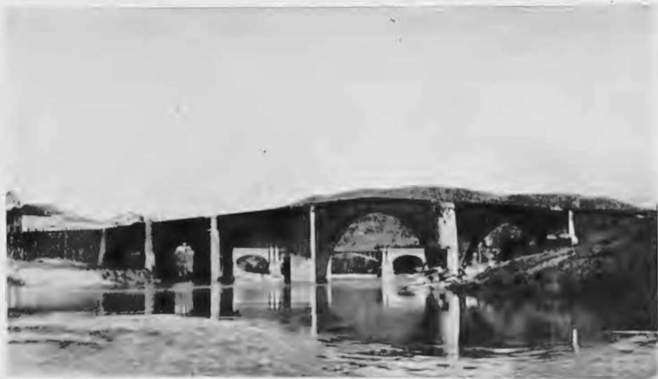
Puente romano de la ciudad de las Burgas}
