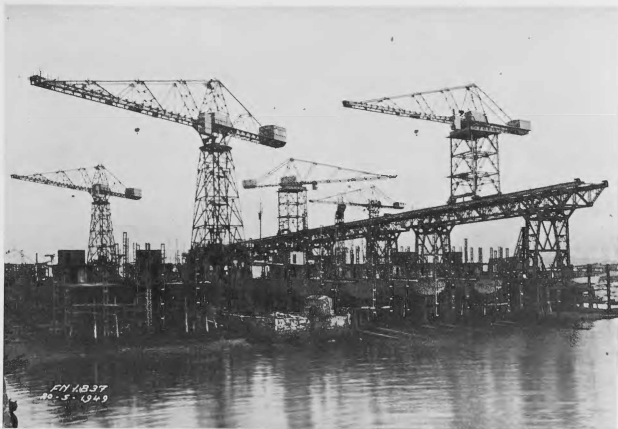
Vista general de las gradas con destructores tipo «Audaz», de popa, y camino de rodamiento elevado
