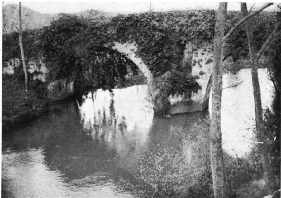
COLLOTO.—Puente sobre el Nora.
