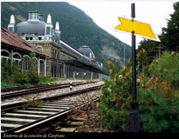
Entorno de la estación de Canfranc
