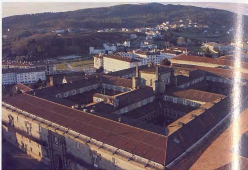
Figura 29: Vista general del Hospital Real. (Archivo R. Yzquierdo).
