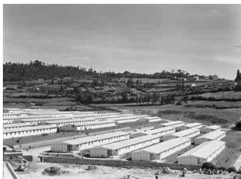
Fig. 13: Rafael de la Hoz Arderius, Javier González-Garra Santoro y Julio Cano Lasso: Albergue en el Burgo de las Naciones (1965). Vista aérea de los pabellones. (Fondo Pando Barrero. Fototeca del Patrimonio Histórico. Instituto del Patrimonio Cultural de España. Madrid)
