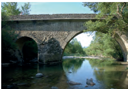
Puente de las Grallas
