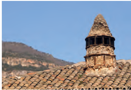
Chimenea en Sigüés
