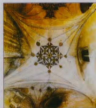
Bóveda capilla Santiago
