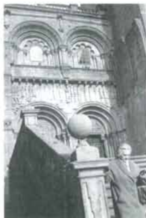
Escaleras de Platerías antes de su restauración.
