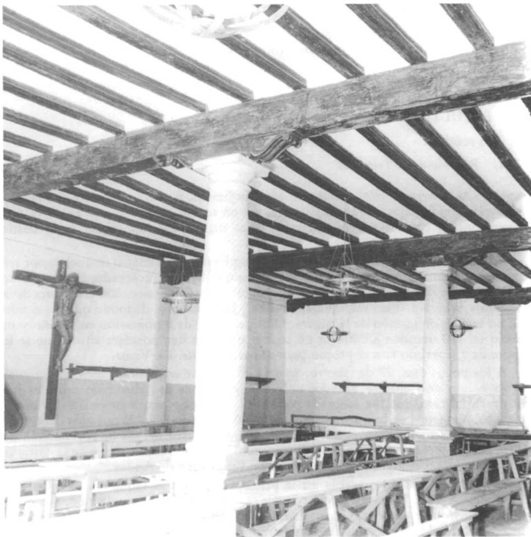
Lám. 10. Sala-comedor y detalle de columna.
