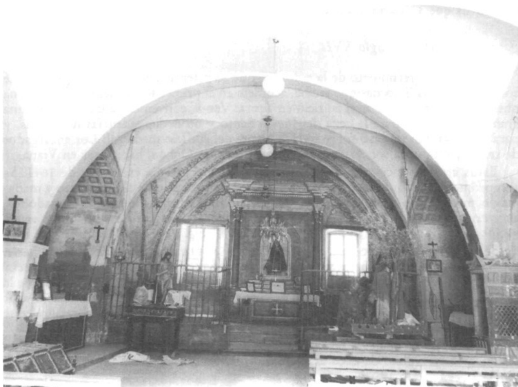
Lám. 9. Bóvedas de yeso del siglo XVII, eliminadas en la restauración.
