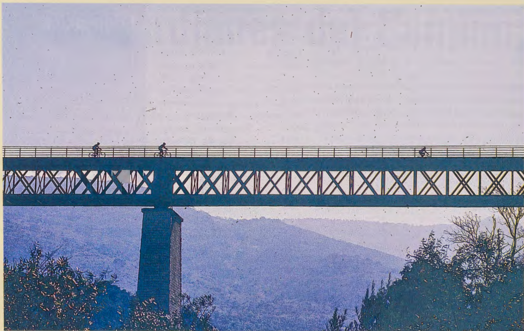
Viaducto del Aceite.
