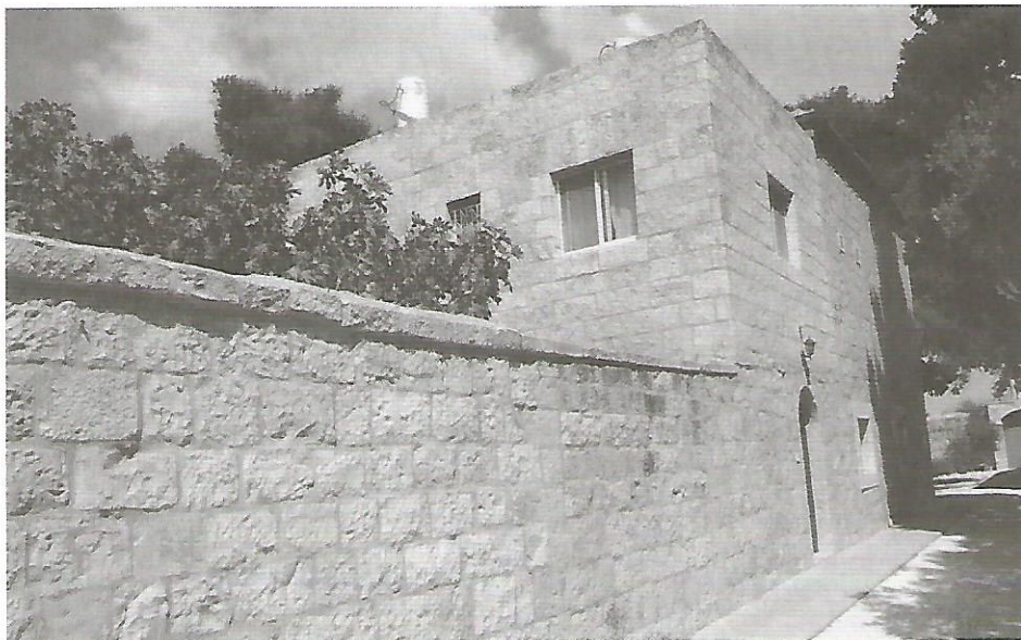
L'ospitale: muro esterno
