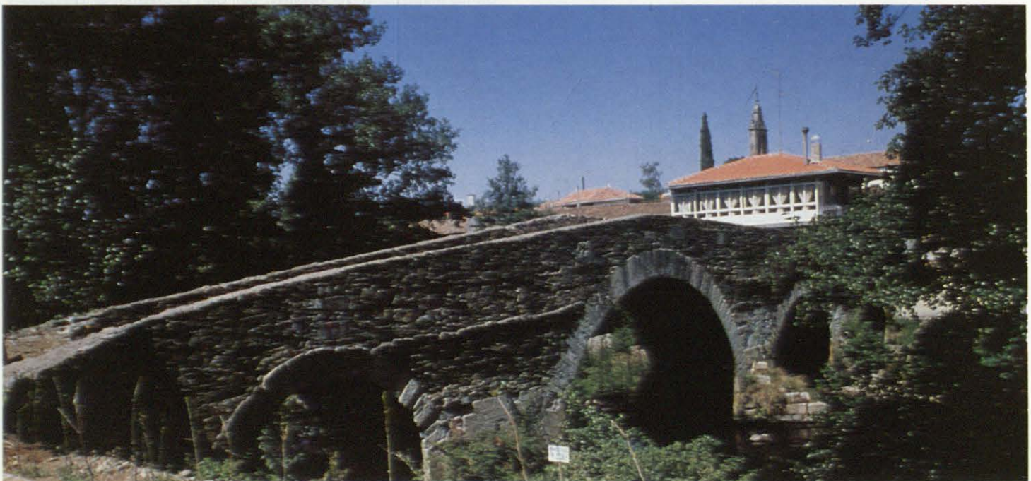
Puente románico con vestigios de calzada. Consta de cuatro arcos desiguales y semicirculares ( restaurados). Furelos.
