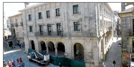
Fachada del Museo a punto de finalizar las obras. El Correo Gallego
