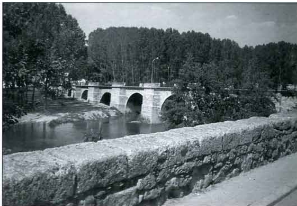
Carrión de los Condes. Puente sobre el río Carrión.
