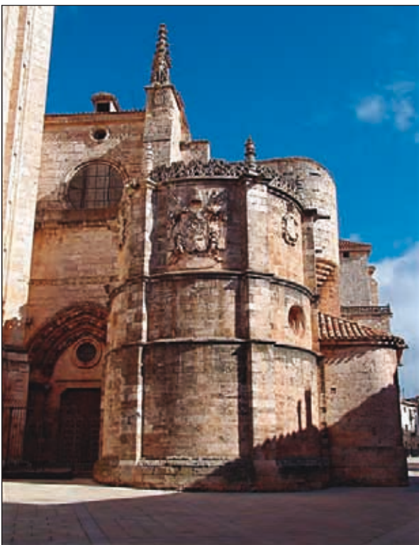
Catedral de Burgo de Osma. Volumen exterior capilla de Santiago
