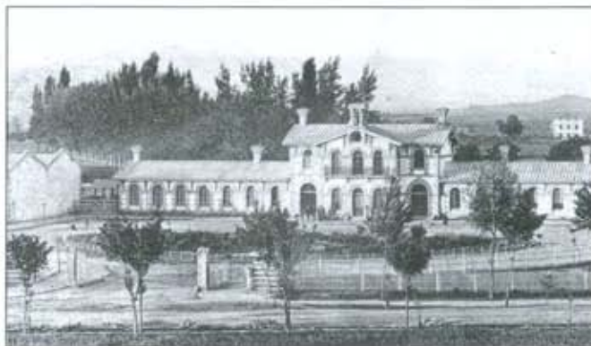
Vista antigua de la estación de Logroño
