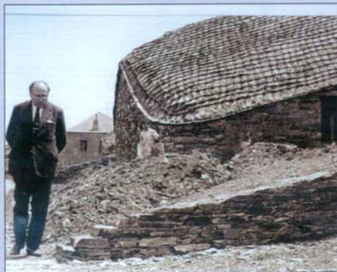
El arquitecto Pons-Sorolla en O Cebreiro durante las obras de restauración. Archivo Villarabid
