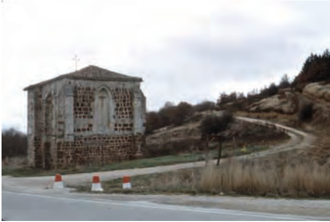
Foto nº 9.-VALDEFUENTES: Ermita, (antiguo hospital de peregrinos), junto al Camino de Santiago.
