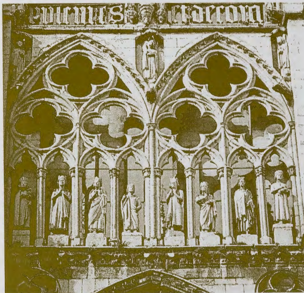
Catedral de Burgos. Detalle de la fachada principal.
