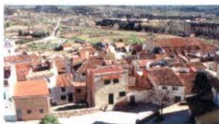
Panorámica y la Iglesia de Santa Águeda desde la Capilla de san Roque.
