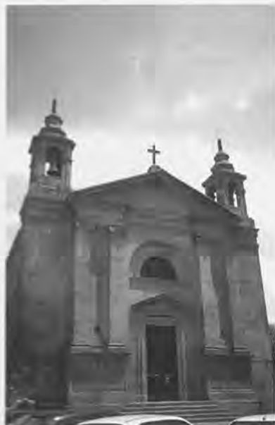
Fachada de la iglesia de Santiago de Padrón.
