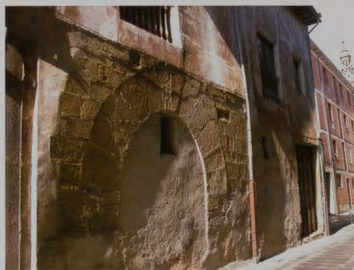
VISTA EXTERIOR DEL EDIFICIO QUE ALBERGARÁ EL CENTRO ANTES DE SU DEMOLICIÓN, UBICADO EN EL N° 33 DE LA CALLE MAYOR, EN PLENO “CASCO ANTIGUO DE LA LOCALIDAD
