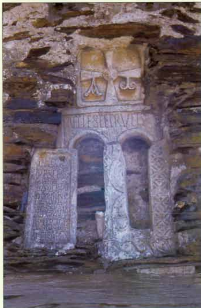
Detalle fachada eremitorio de la Santa Cruz. San Pedro de Montes. León.
