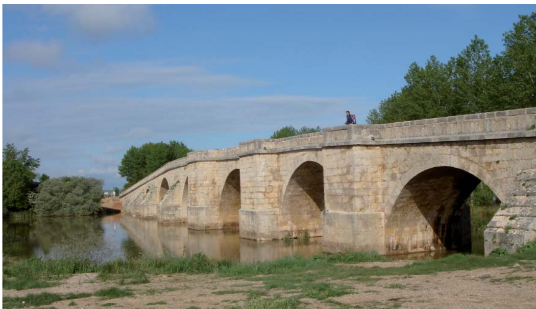
Figura 8. Puente de Itero sobre el río Pisuerga (Itero del Castillo, Burgos).
